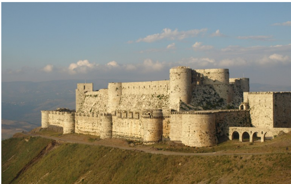
Obr. 14: Johanitská pevnost Crac des Chevaliers.
