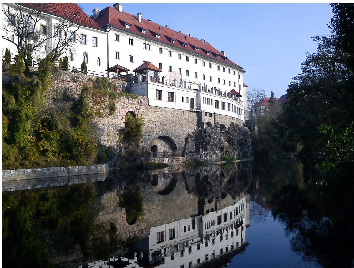
Obr. 15: Českokrumlovská jezuitská kolej.
