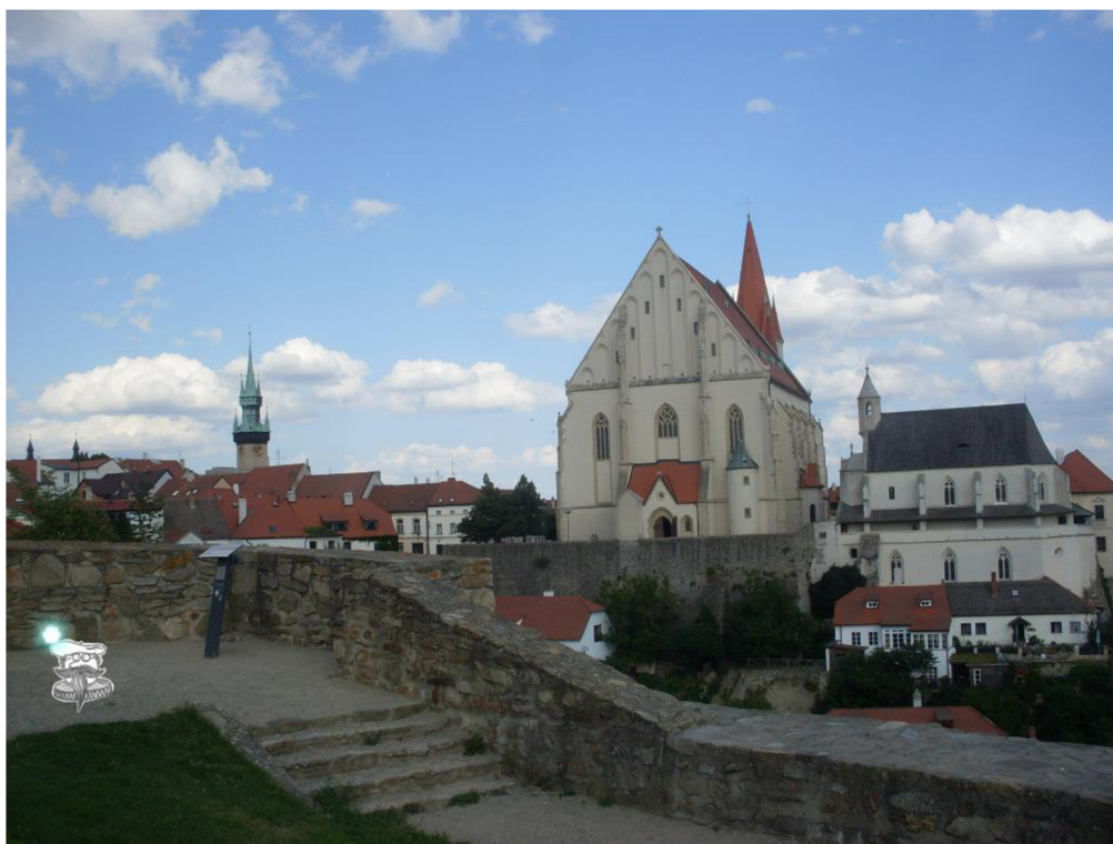
Obr. 18: Scéna 6 – Kostel sv. Mikuláše a Svatováclavská kaple
