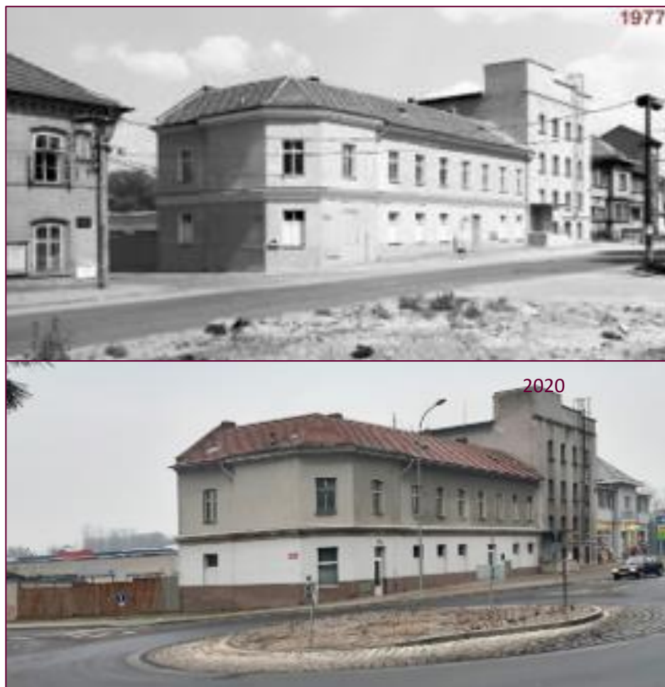
Obrázek 8.7-1: Mělník budova Okresního stavebního podniku a pivovar – snímky z roku 1977 (p. Lojka a 2020 Veronika Švejdová)
