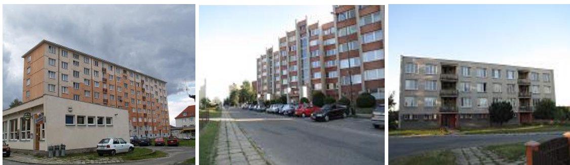
Obrázek 7 – Bytová výstavba v druhé polovině 20. století. Foto autor
