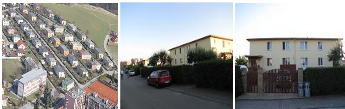
Obrázek 9 – Kolonie Amerika. Na leteckém snímku (J.Karlovský) lze pozorovat koncepci výstavby. Na prostředním snímku a na snímku vpravo je ulice Komenského v kolonii Amerika, která patří k nejlépe zachovalým částem města s typicky baťovskou architekturou. Foto autor
