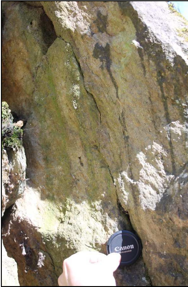
Obr. 13: Detail výchozu lomové stěny (M. Farský, 26. 3. 2017)
