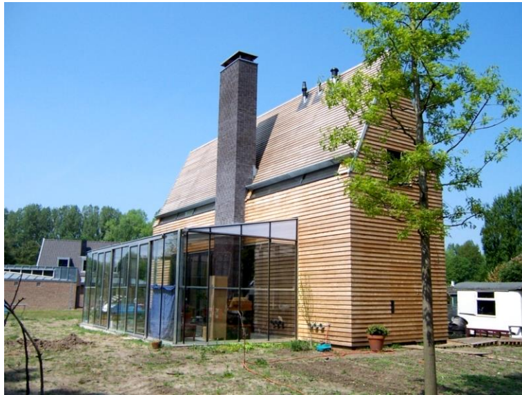
Obr. 52 Využití PlatoWood dřeva pro venkovní obklad budov ( www.platowood.nl )
