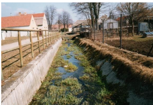
Obr. 15 Třebonínský potok – v obci je veden v betonových panelech (foto: Studie o stavu hydrografické sítě, povodí Třebonínského potoka)
