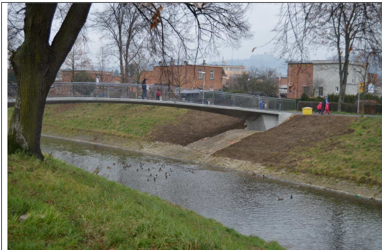
Foto 031: Lávka v km 14,544
