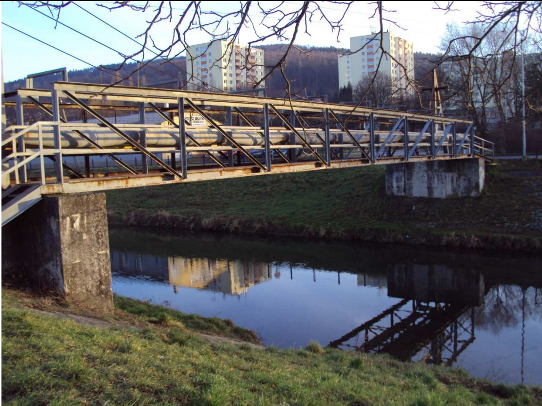
Foto 013: Lávka v km 9,964
