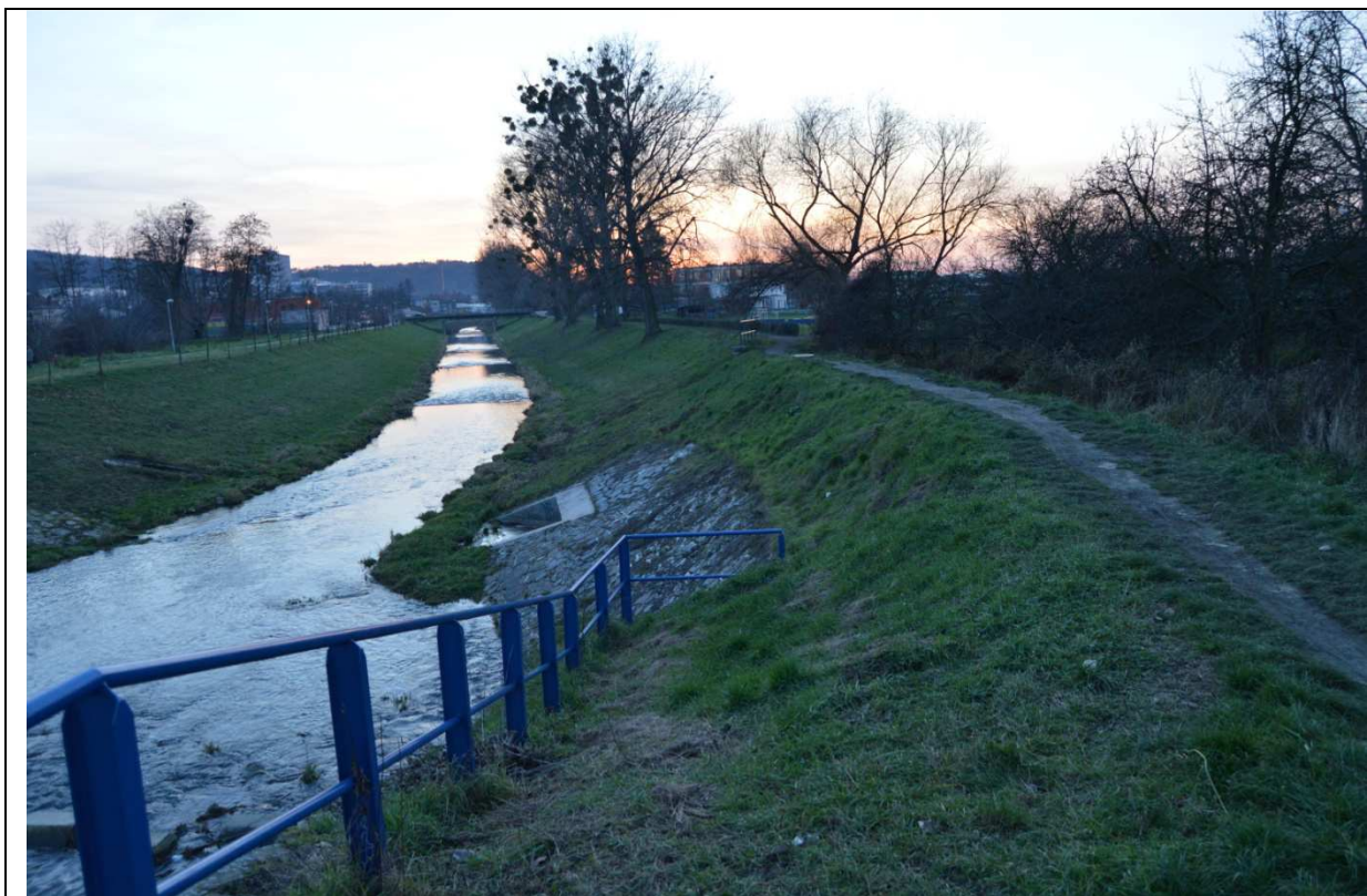
Foto 011: Jez louky v km 9,398 s výpustí
