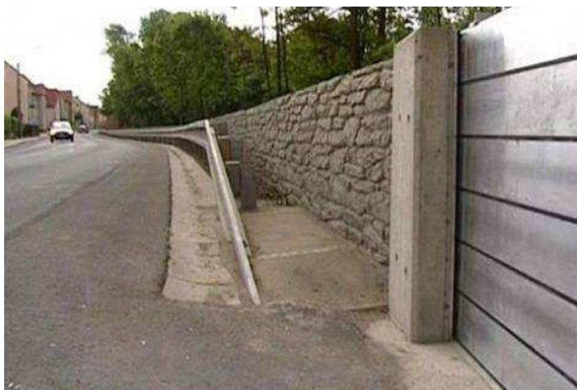
Obrázek 7.4 Příklad kombinované povodňové zdi [13]
