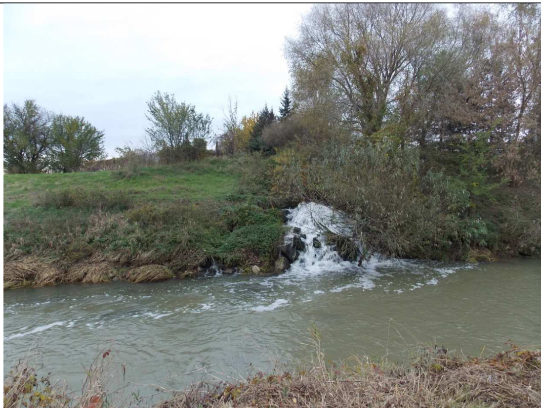
Foto 004: Výtok z ČOV v km 5,324
