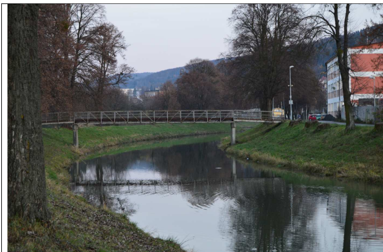
Foto 012: Lávka v km 9,649
