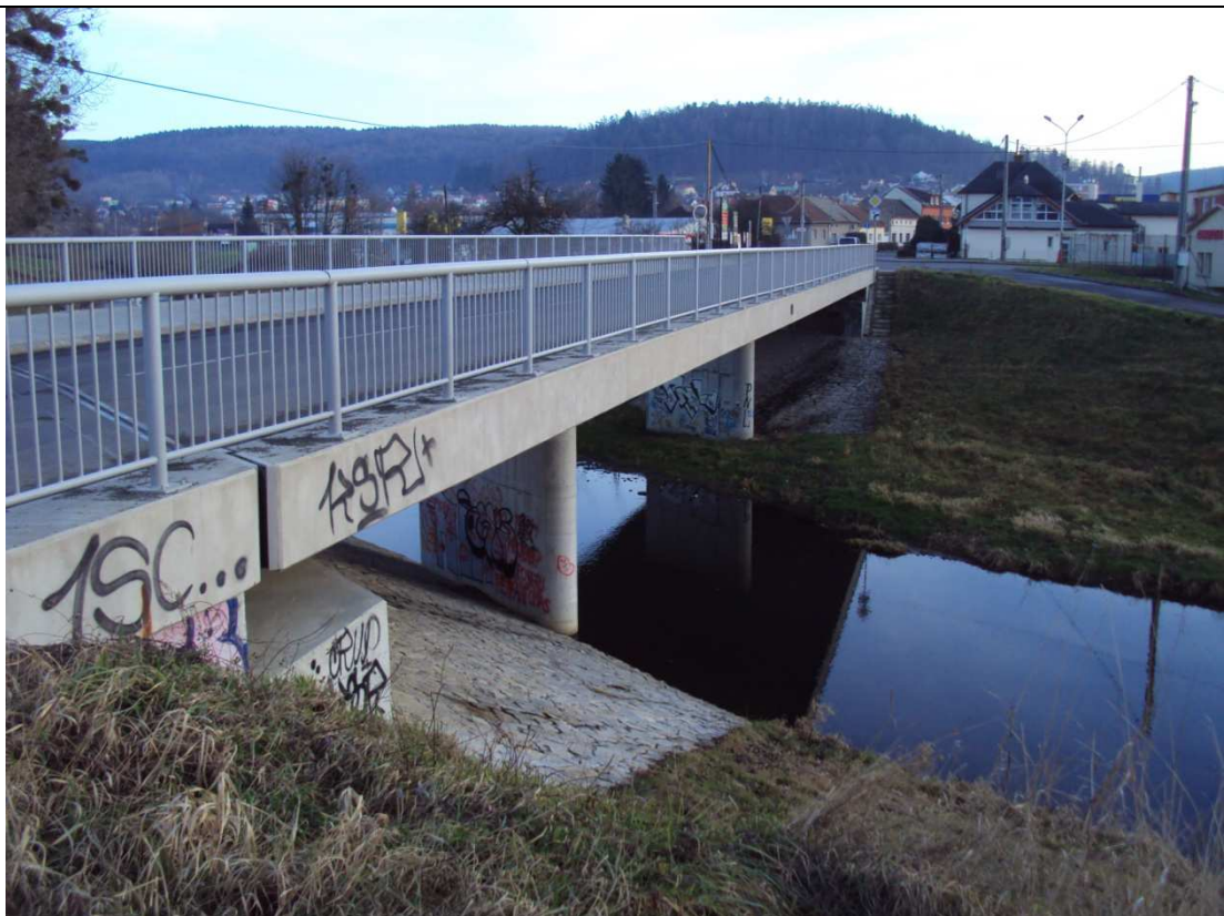
Foto 006: Silniční most Tečovice - Malenovice v km 6,915
