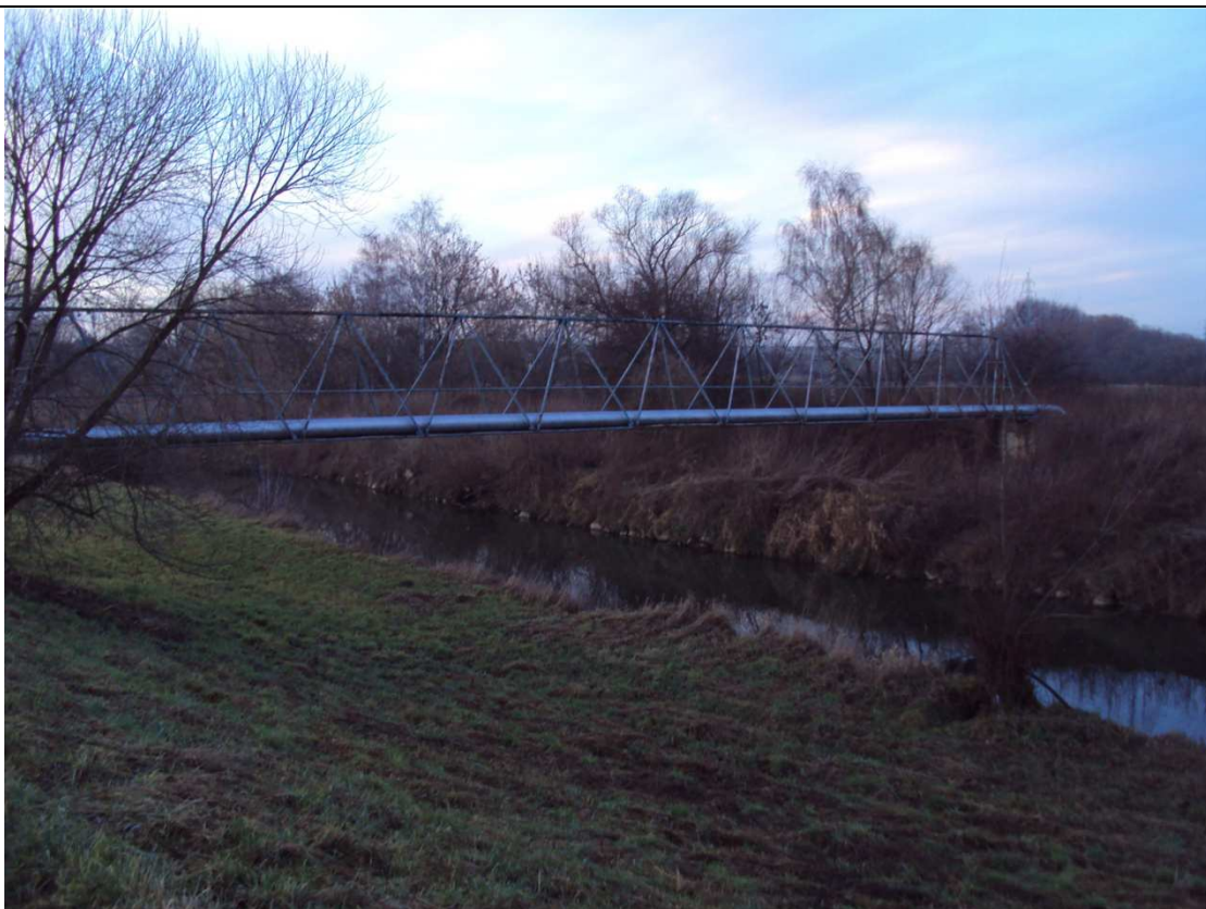
Foto 003: Lávka + plynovod v km 4,128
