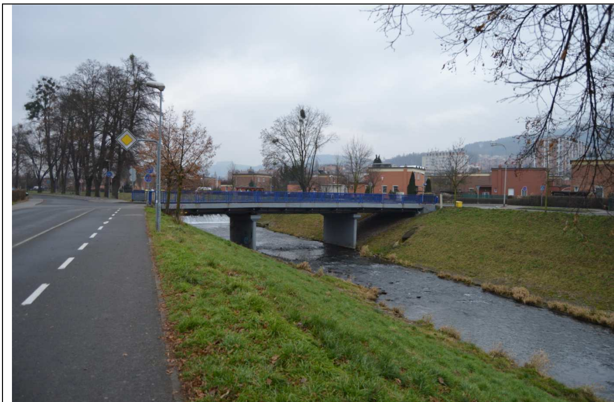
Foto 029: Silniční most Zálešná-Podvesná a výpust v km 14,082
