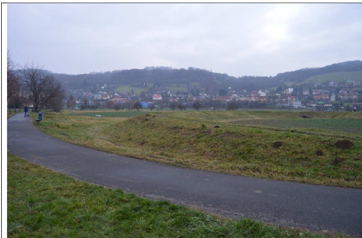
Foto 040: Pohled na suchý poldr v km 16,633
