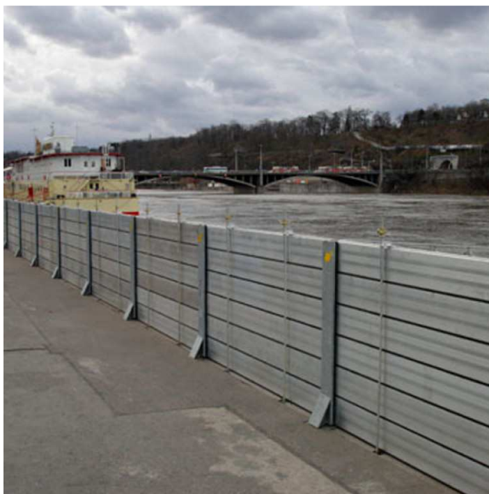
Obrázek 7.3 Příklad mobilní protipovodňové zdi [12]
