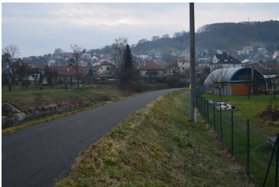
Obrázek 7.1 Fotografie protipovodňového hrázkování podél toku Dřevnice v km 16,21 – 18,341
