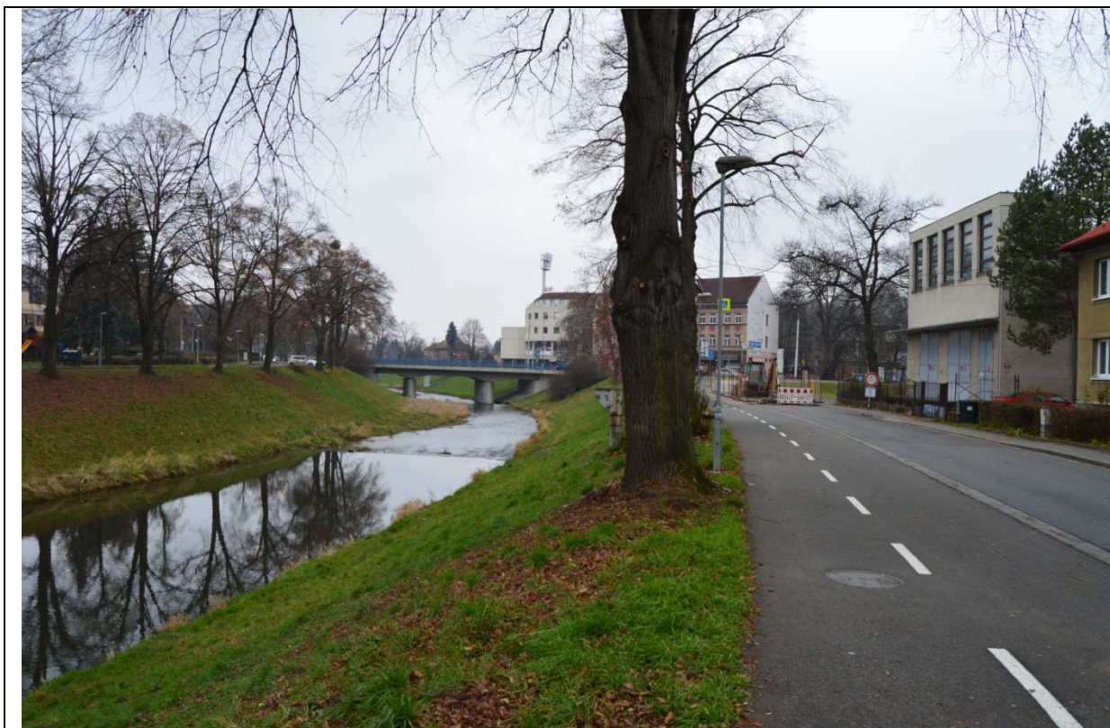
Foto 021: Silniční most Cigánecký v km 13,233 a práh v km 13,337
