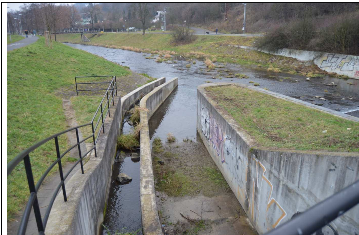
Foto 039: Jez Příluky II v km 16,125
