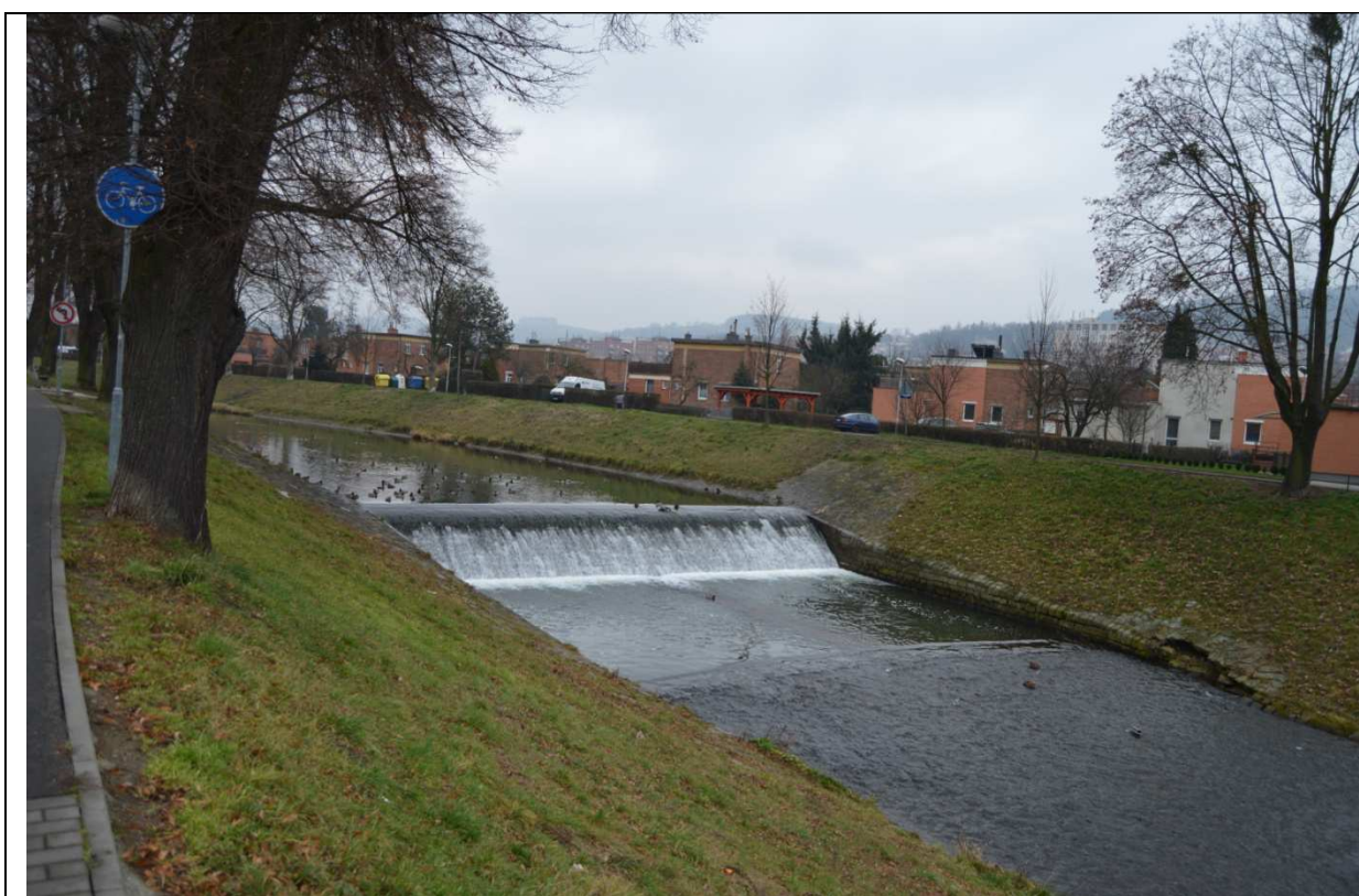
Foto 030: Jez Podvesná v km 14,125
