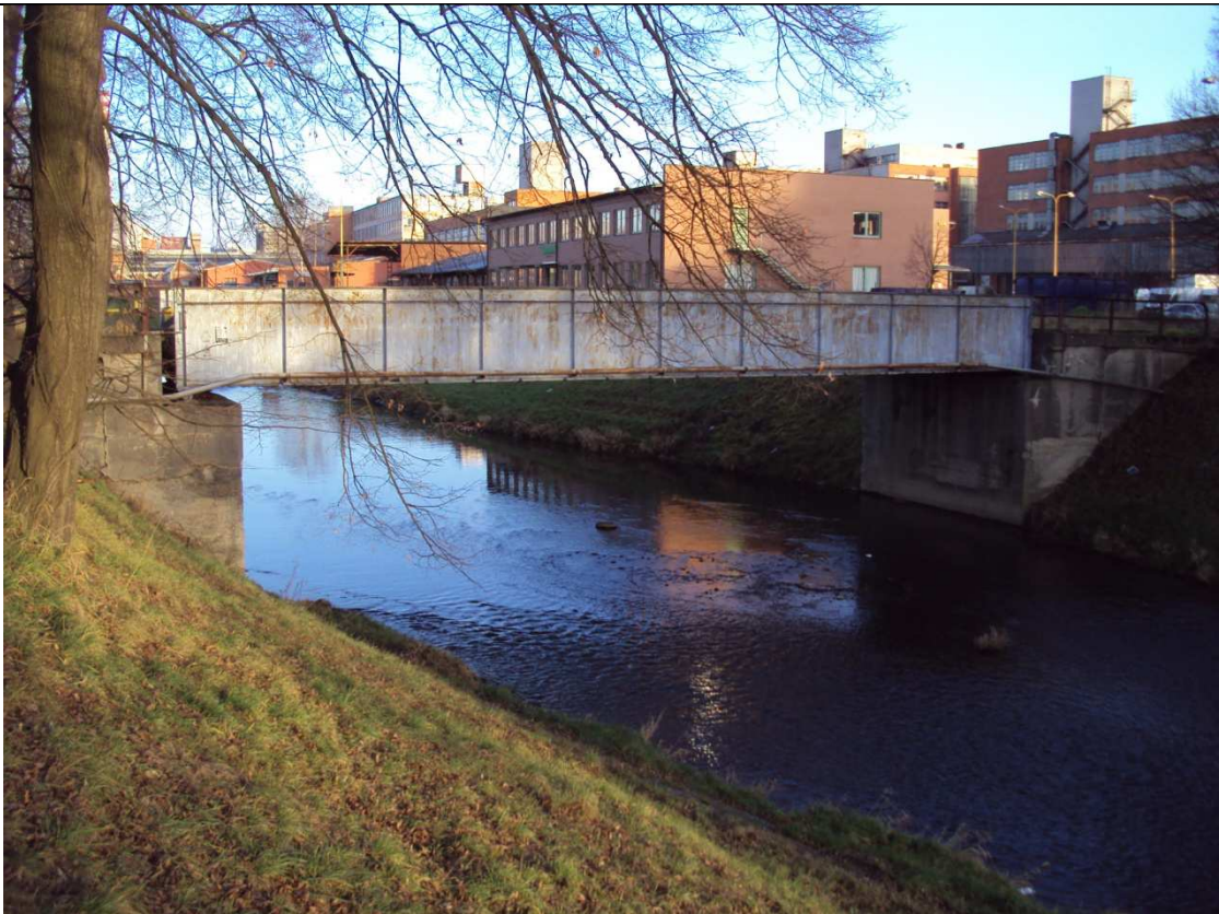
Foto 016: Vlečkový most v km 10,817
