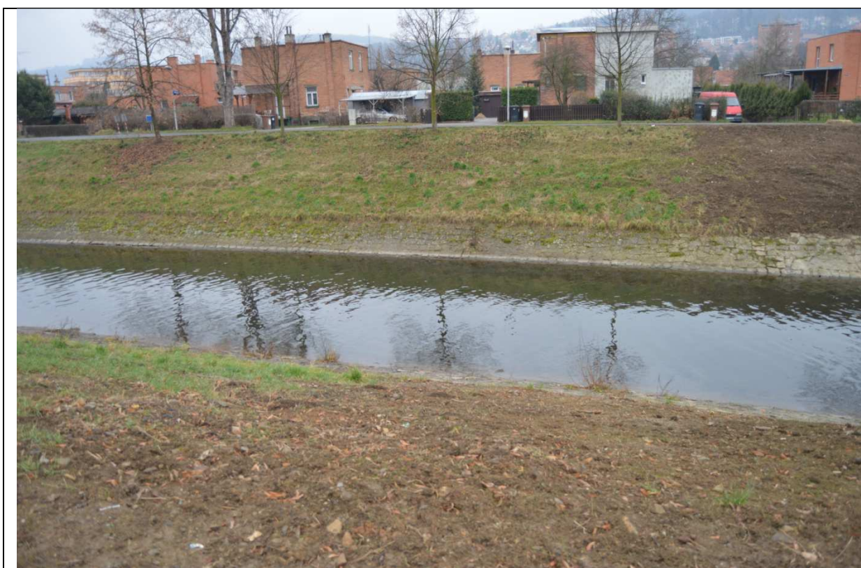
Foto 032: Opevnění v km 14, 550
