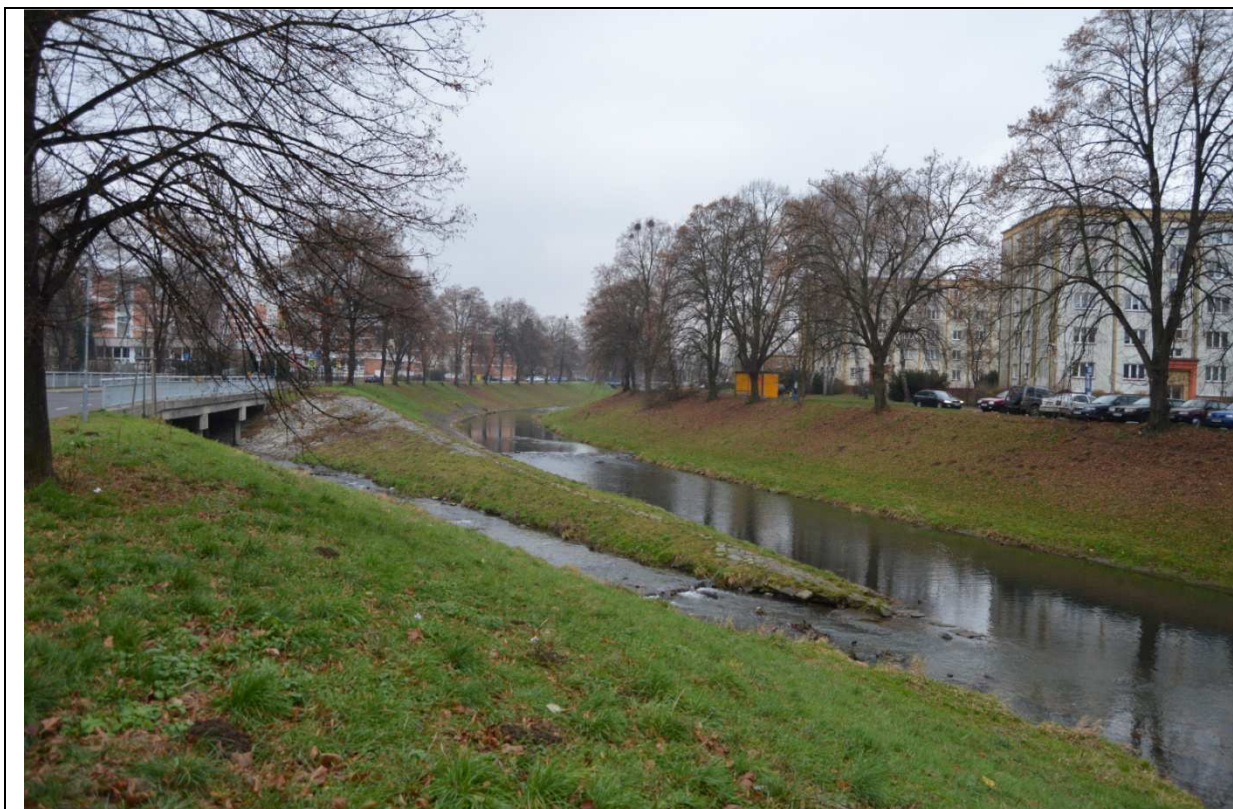
Foto 027: Soutok Dřevnice, Fryštácký potok v km 13,780
