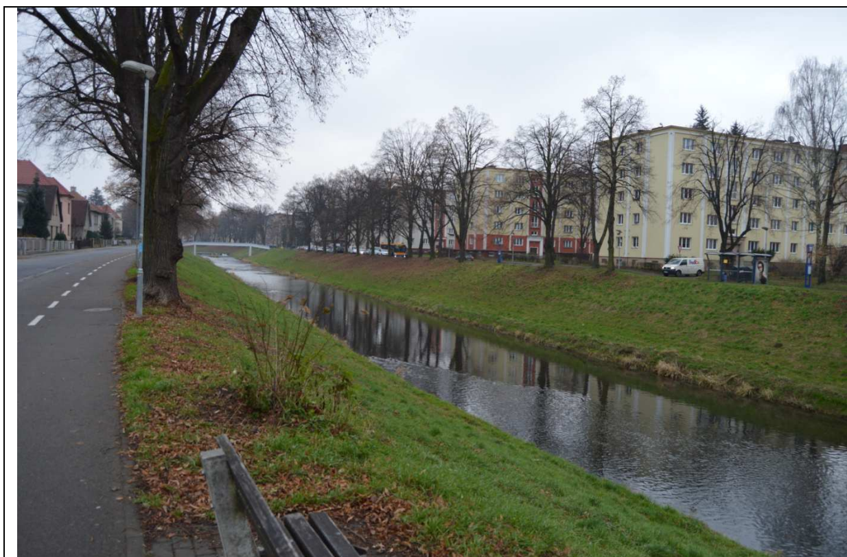
Foto 024: Lávka v km 13,613
