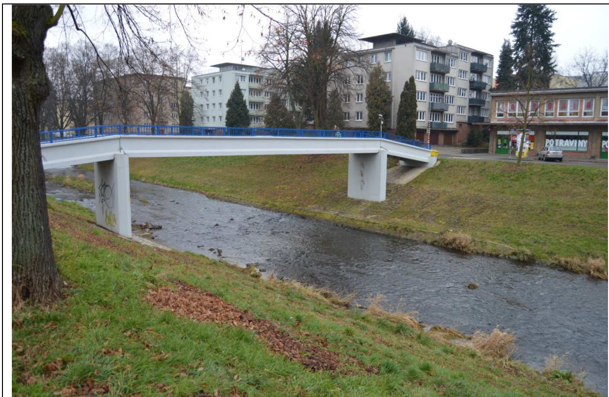
Foto 025: Lávka v km 13,613
