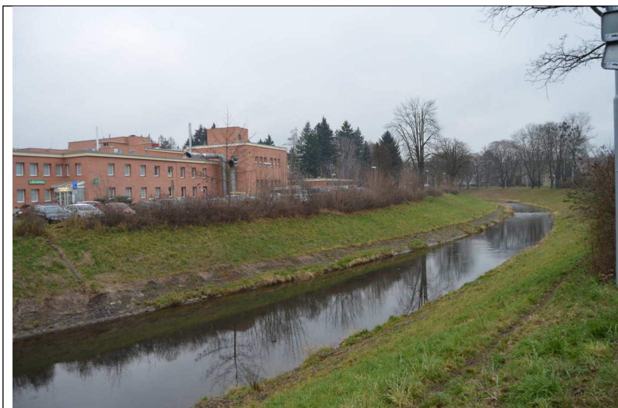
Foto 034: V pozadí práh v km 14, 943
