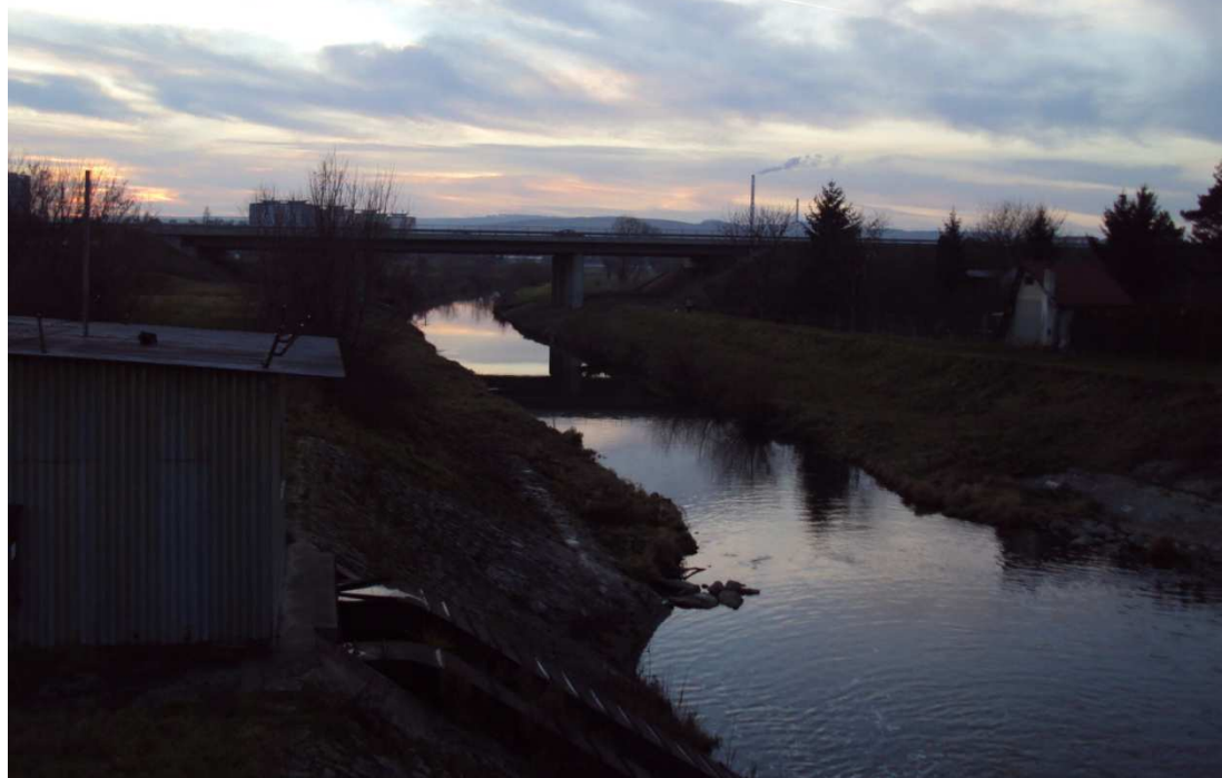
Foto 001: Dálniční most v km 3,379
