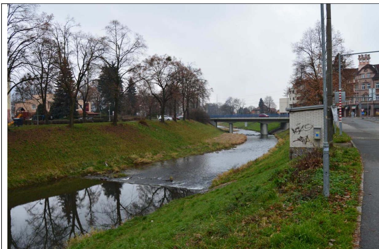
Foto 022: Most v km 13,233, práh v km 13,337 a limnigrafická stanice v km 13,340
