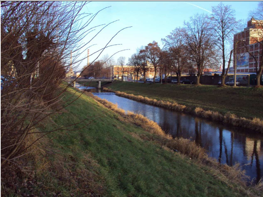
Foto 014: Silniční most Prštné v km 10,493
