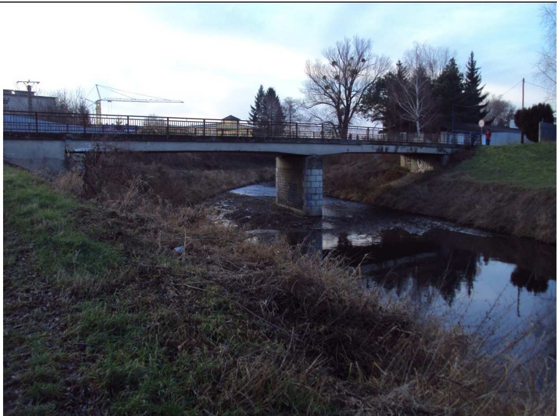
Foto 005: Silniční most u ČOV v km 5,586
