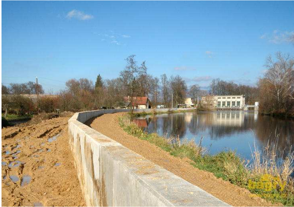
Obrázek 7.2 Příklad stabilní protipovodňové zdi [11]
