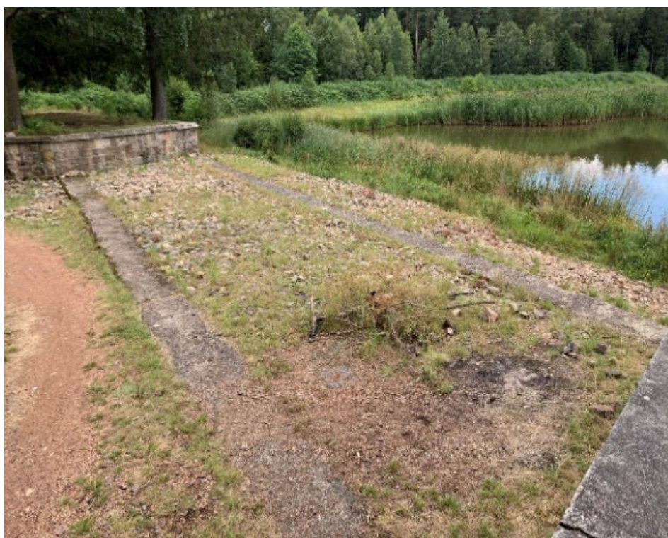
Obrázek 9 – bezpečnostní přeliv Hořejšího Padrt'ského rybníka (zdroj: vlastní)
