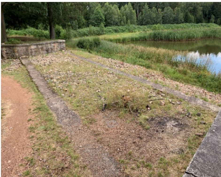
Obrázek 9 – bezpečnostní přeliv Hořejšího Padrt'ského rybníka (zdroj: vlastní)
