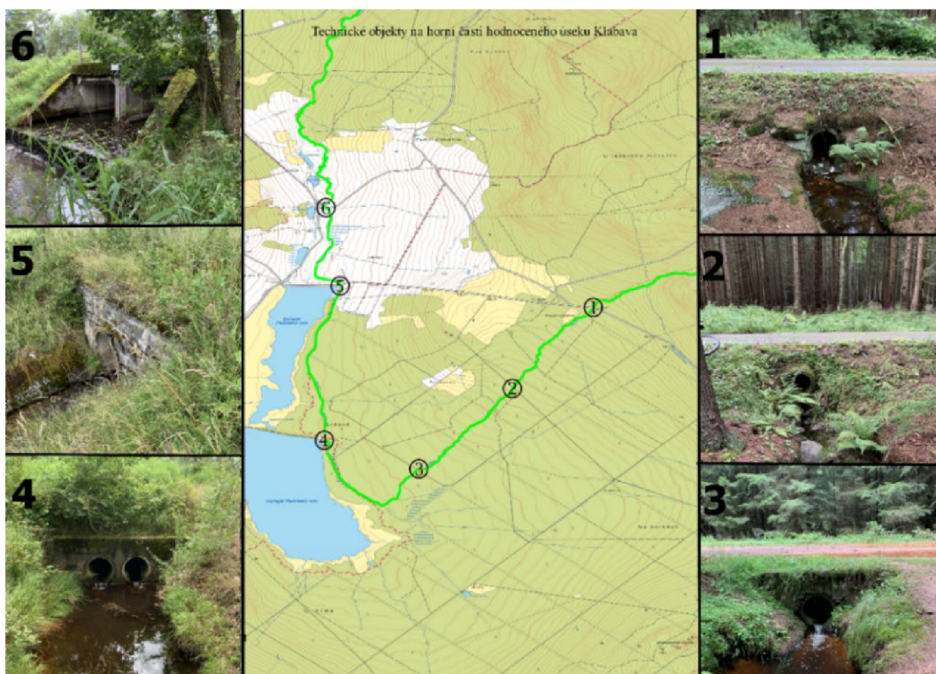
Obrázek 7 – technické objekty na horní části hodnoceného úseku: 1- propustek Padrtě-Nepomuk, 2 – propustek pod Altánskou cestou, 3 – propustek pod stezkou k Poličce, 4- propust' Hořejší Padrtský rybník, 5 – propustek Dolní Padrtský rybník, 6- most na Naučné stezce (zdroj: vlastní)
