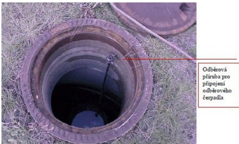
Obr. č. 23 Lapol č. 3 v zadním rohu budovy u skladu chemických látek
