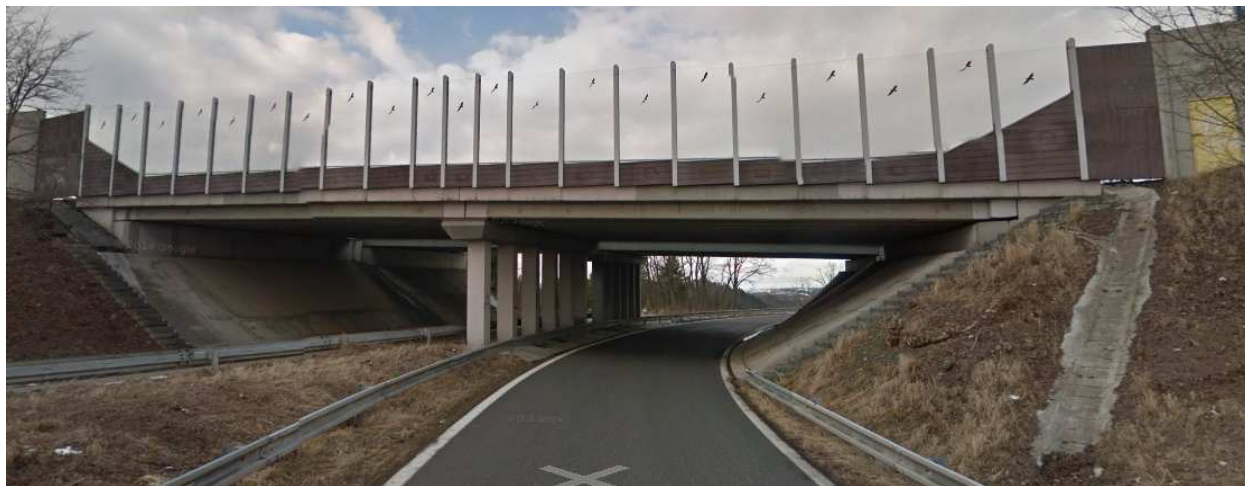
Obr. 1 Stávající mostní konstrukce
