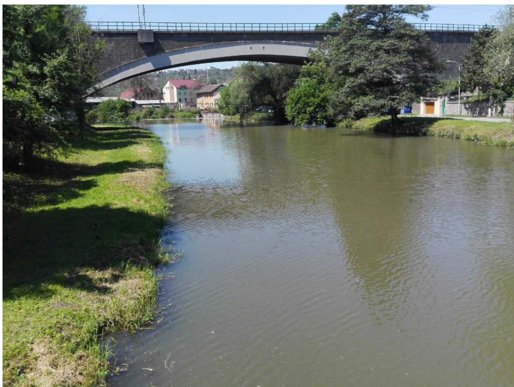
Obr. 33: pohled na nadjezí směrem k jezu v Obřanech
