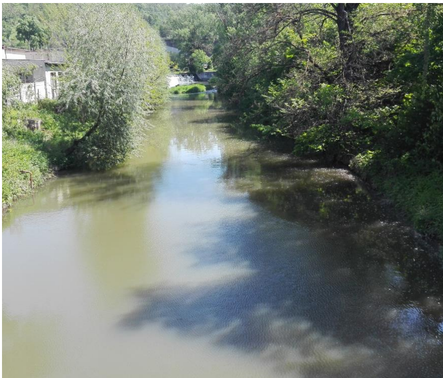
Obr. 34: pohled na podjezí směrem k jezu v Obřanech
