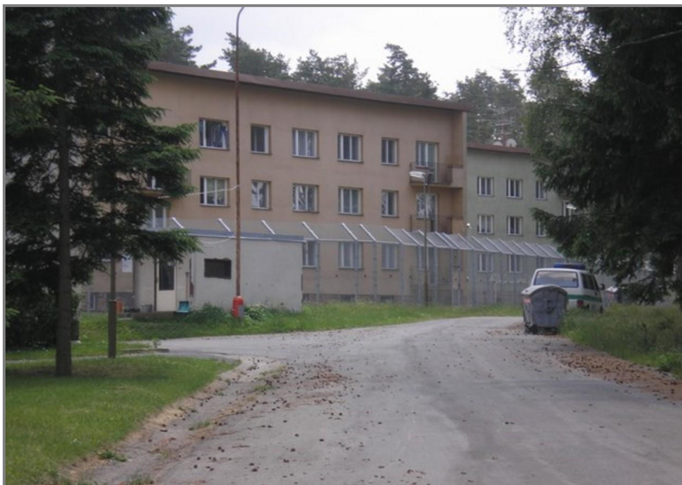
Obrázek č. 14 – Zařízení pro zajištění cizinců Bělá - Jezová
