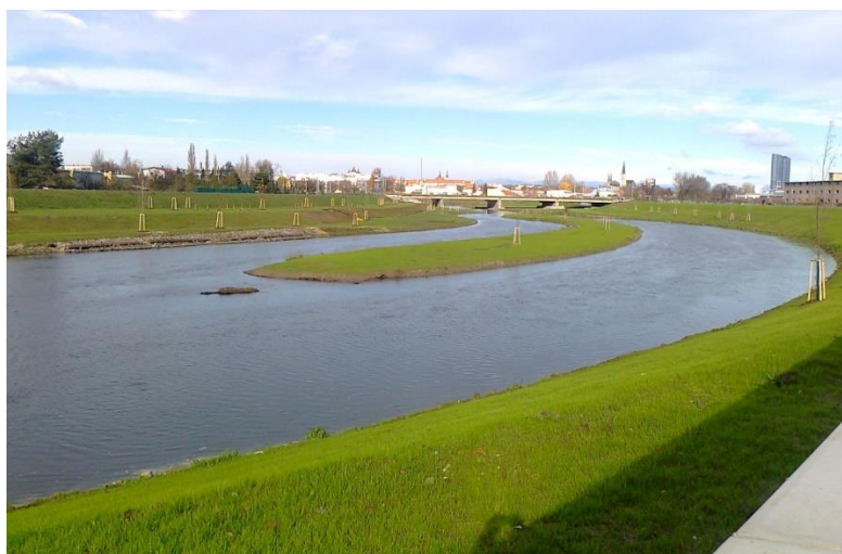
Obrázek 49 Paralelní koryto se zeleným ostrovem pod ul. Velkomoravská (Protipovodňová opatření Olomouc 2016)
