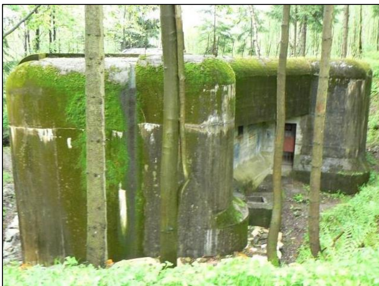
Obr. 39. NS II. Pěchotní srub ST.M. – S 50 „U Trati“. (7/2020)
