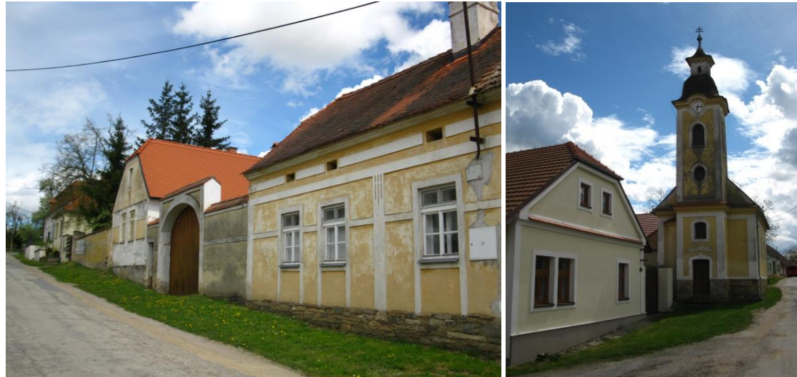
Obrázek 48: Původní dům a kamennou podezdívkou a zdobenou fasádou.
