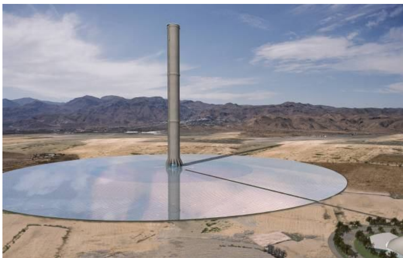
Obrázek 15: Ukázka solární komínové elektrárny. [36]
