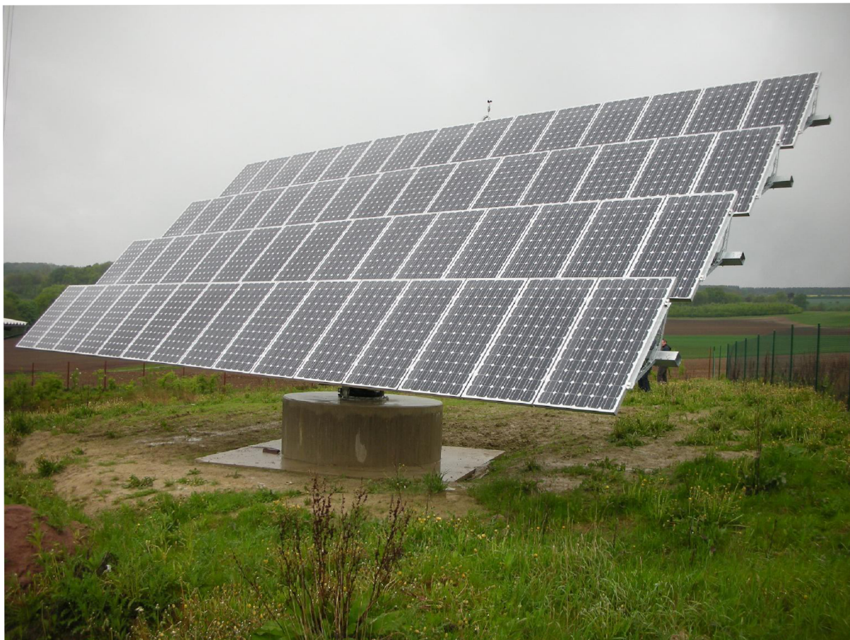
Obrázek 7: Upevnění modulů na polohovacích jednotkách. [25]
