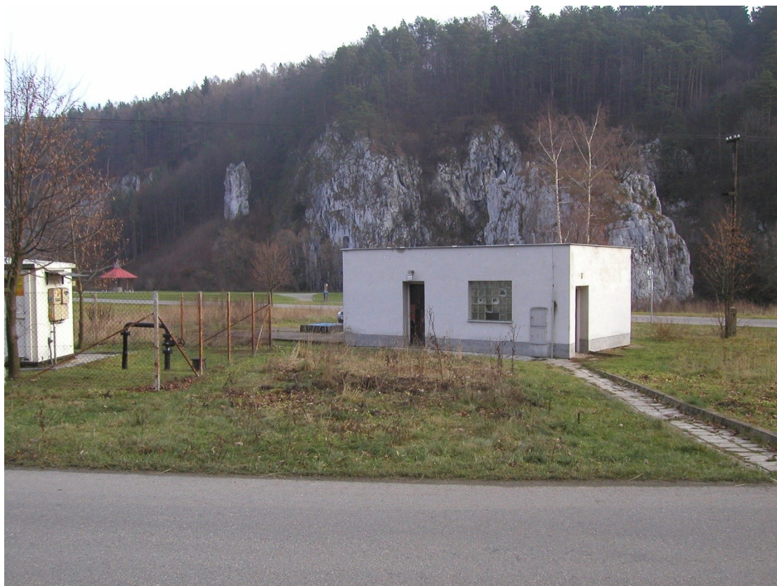
Obr. 11.3 Objekt mechanického předčištění [51]
