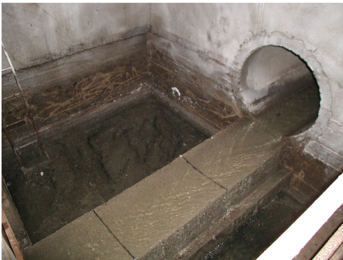
Obr. 11.2 Odlehčovací komora na přítoku do ČOV [51]
