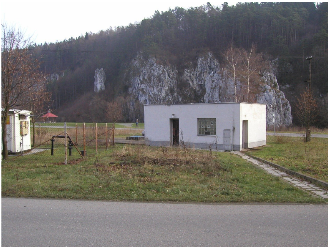
Obr. 11.3 Objekt mechanického předčištění [51]
