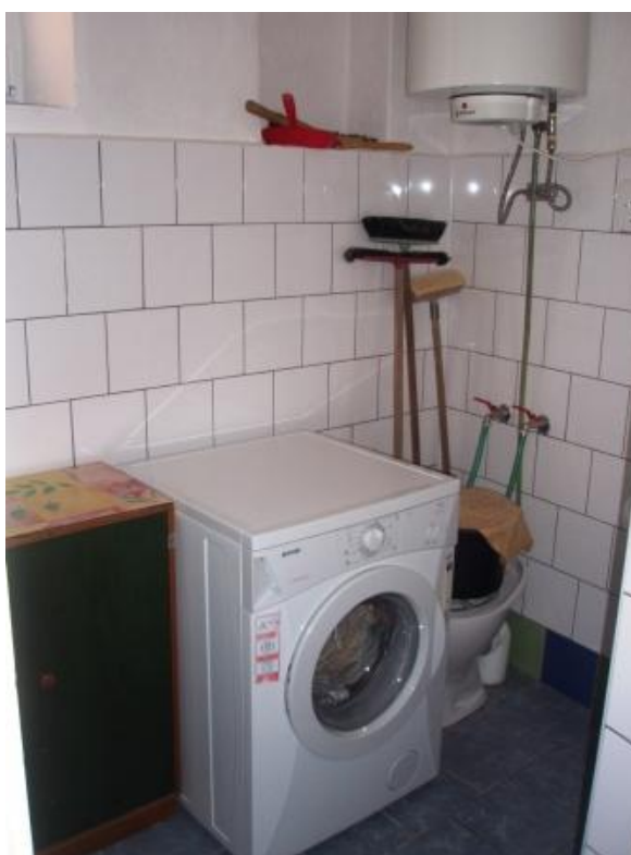
Obr. č. 20 Úklidová místnost – automatická pračka, výlevka, skříňka na dezinfekční prostředky (kuchyně ZŠ)
