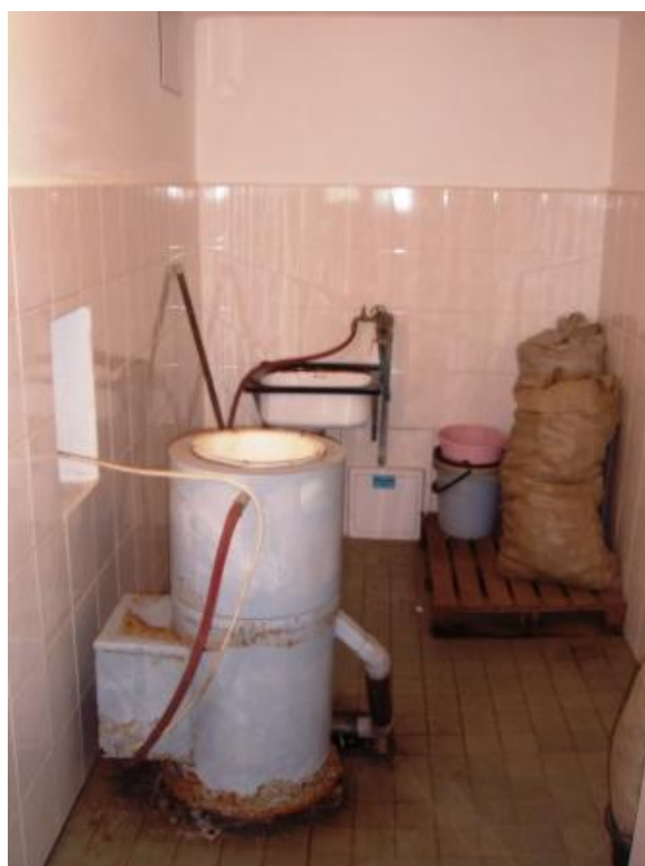
Obr. č. 14 Sklad brambor – škrabka brambor, uskladnění brambor (kuchyně ZŠ)
