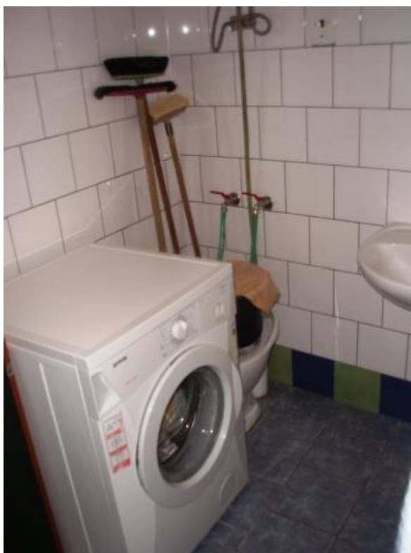
Obr. č. 21 Úklidová místnost (kuchyně ZŠ)
