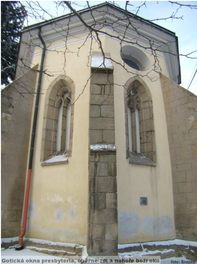
Gotická okna presbyteria, opěrné zdi a nahore boží oko foto: Šnejdar
