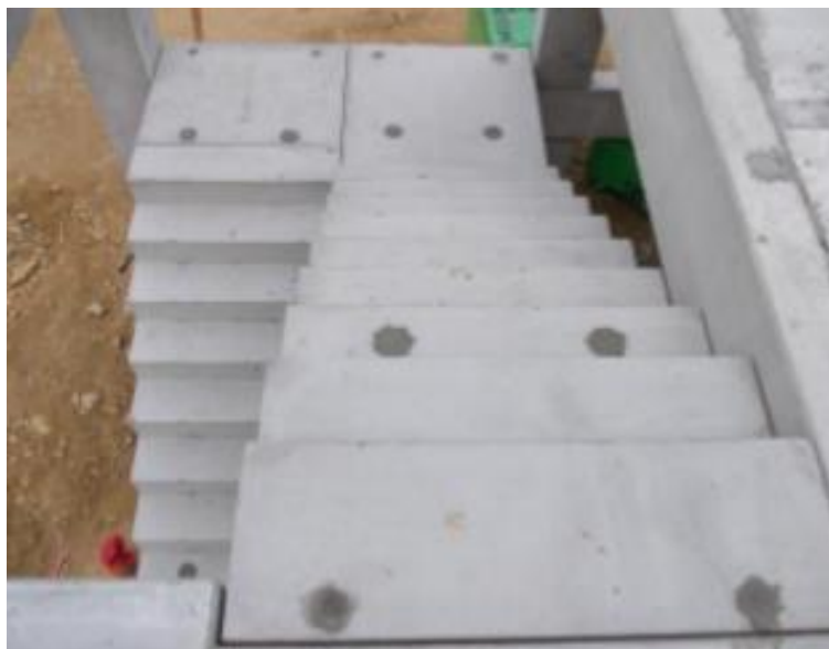
Obrázek 4 - Ilustrační foto zapravení montážních úchytů.
