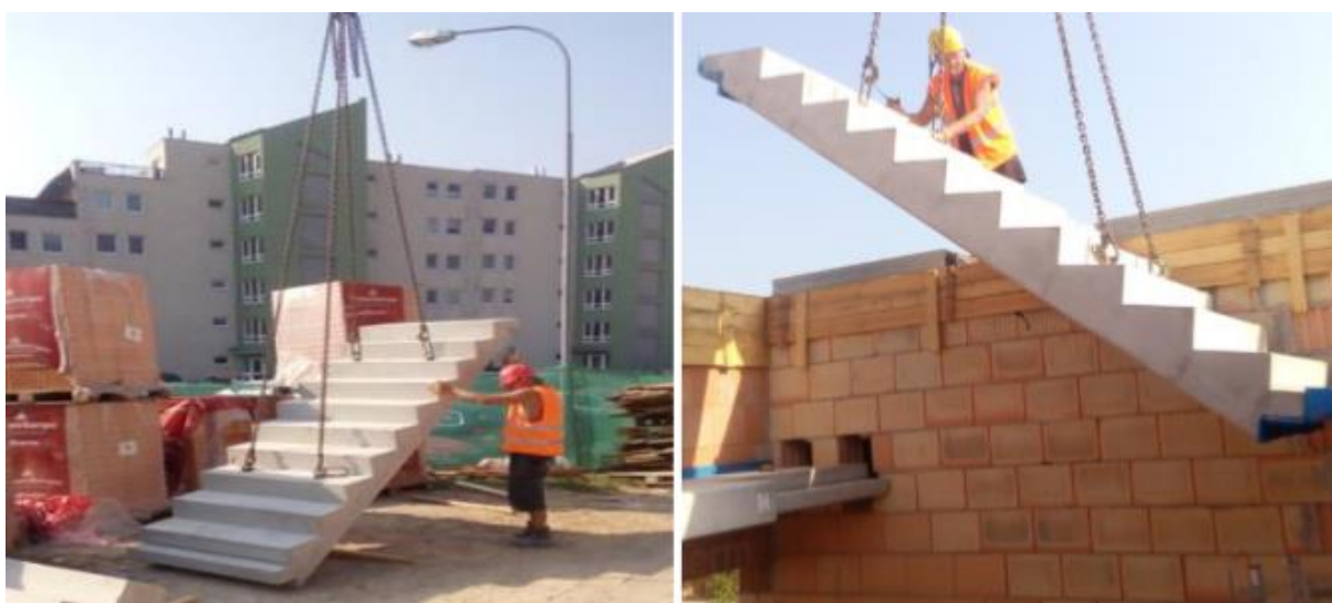
Obrázek 5 - Ilustrační záběry manipulace se schodišťovým ramenem.
