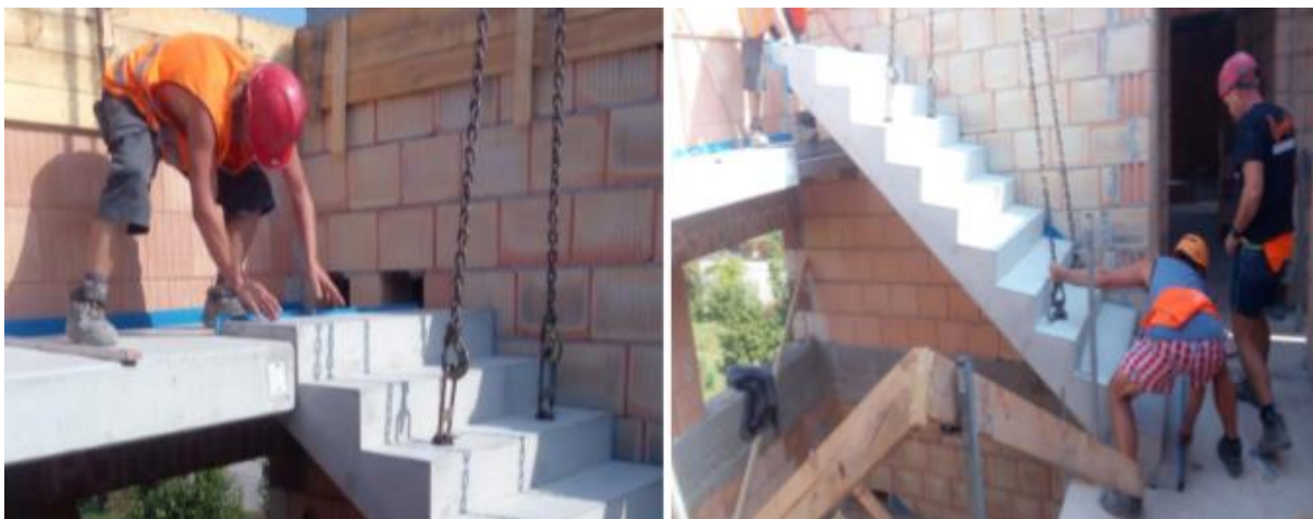
Obrázek 6 - Ilustrační foto ukládání schodišťového ramene.
