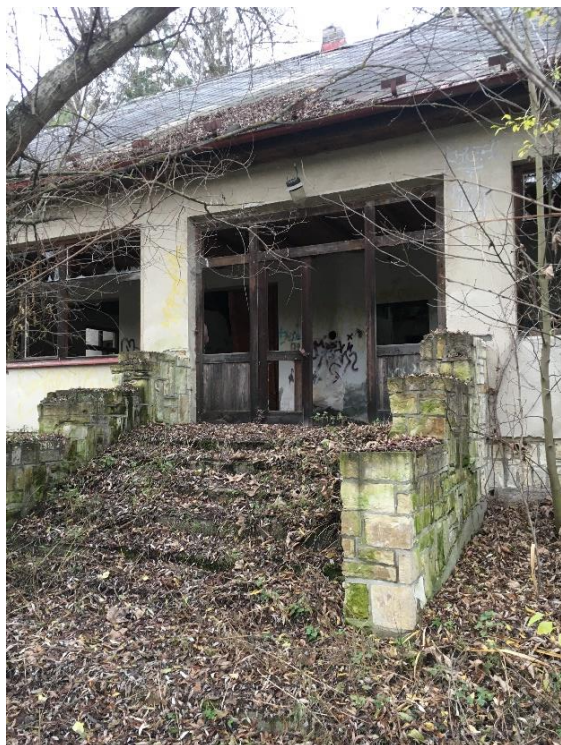
Obr. č. 4: Příklad zdevastované budovy – bývalé koupaliště ve Družci
