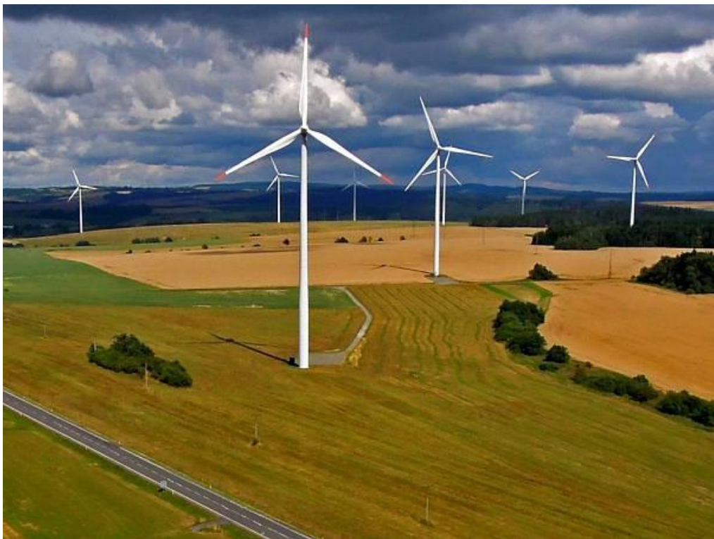
Obrázek 22 Větrný park Horní Loděnice - Lipina, © Jiří Kopáč.
