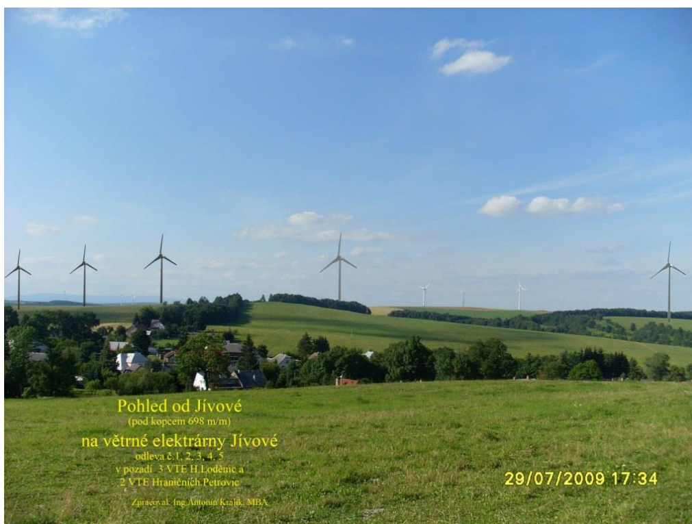
Fotovizualizace č. 4: Pohled od Jívové na pět větrných elektráren záměru firmy Ventureal.
