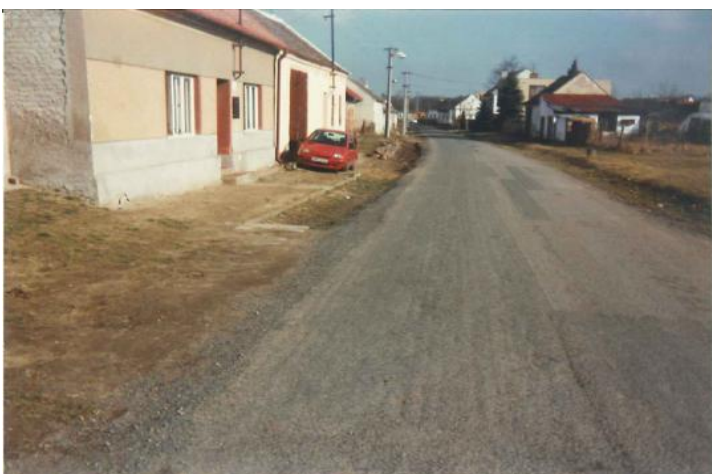
Ulice Drnholecká před úpravou
