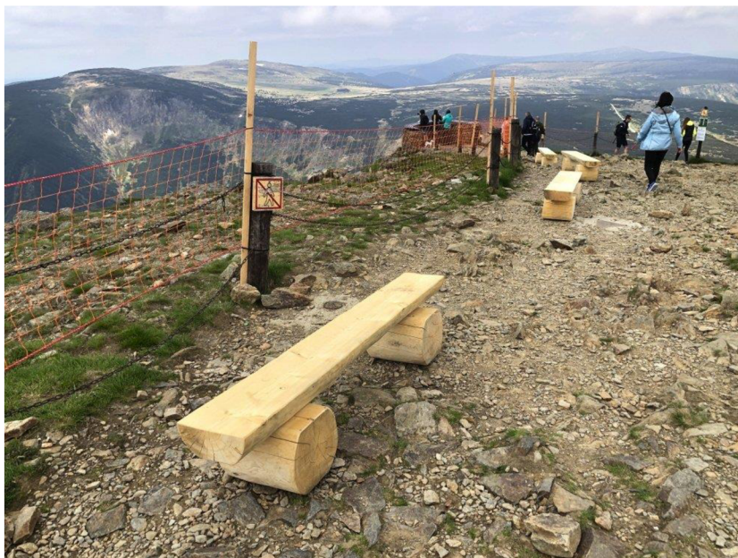
Obrázek 6: Instalace vysokých oranžových sítí a přidání dřevěných laviček na Sněžku Zdroj: irozhlas.cz, 2020
