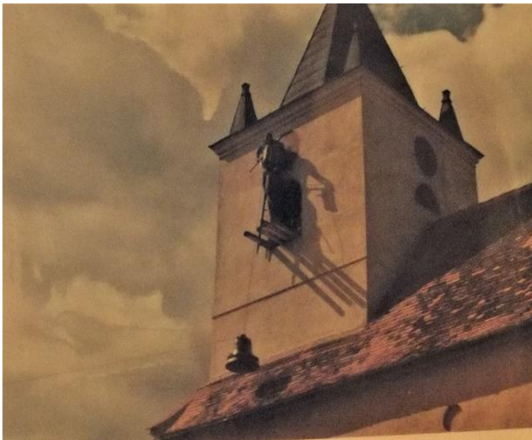
Příloha č. 19. Instalace zvonů na věž roku 1990.
