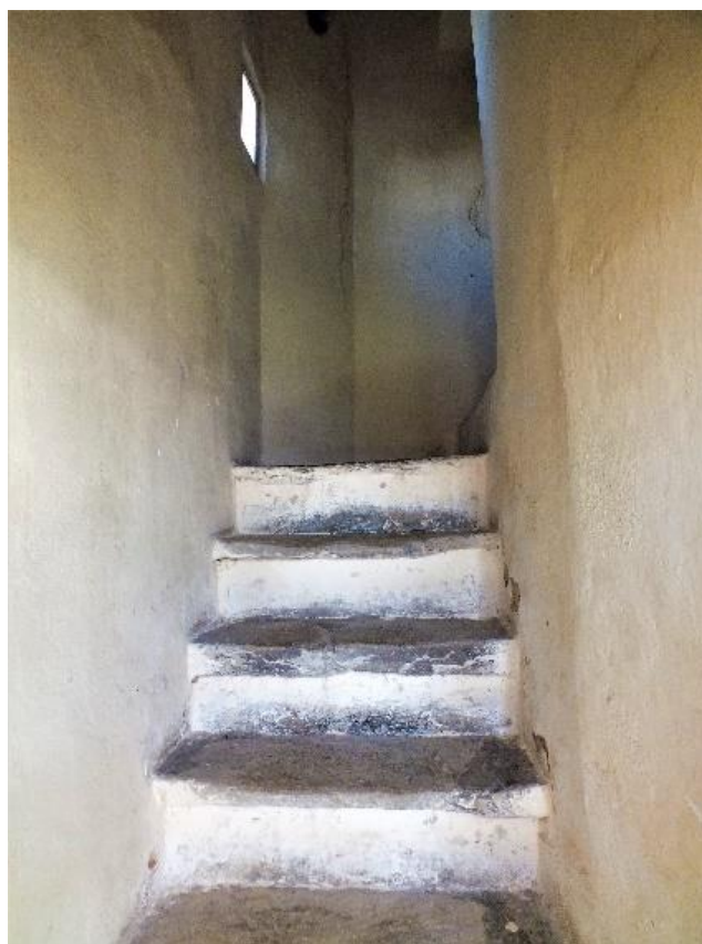
Příloha č. 29. Schodiště vedoucí na kůr.
