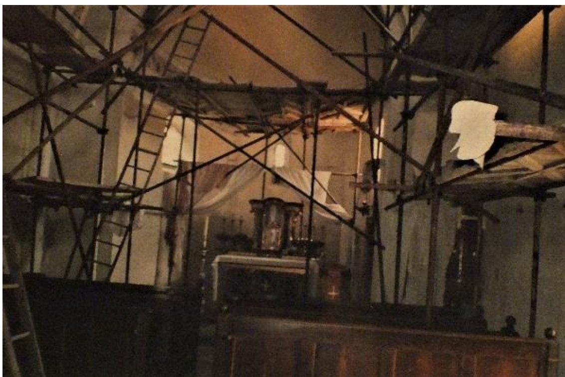
Přílohy č. 16, 17. Fotografie zachycující pohled do interiéru kostela v průběhu oprav v letech 1999–2001.
