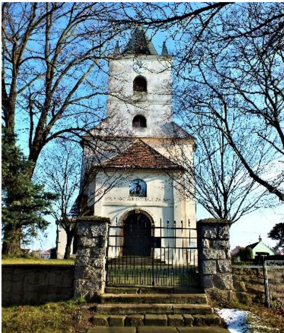
Příloha č. 22. Zápvní průčelí kostela s hlavním vchodem.
