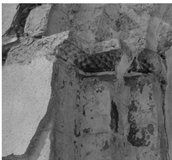
Přílohy č. 11, 12. Odhalený románský portál na začátku rekonstrukce v 80. letech 20. století.
