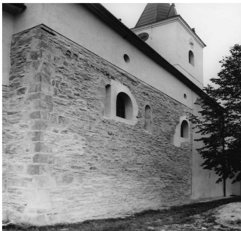
Přílohy č. 13, 14. Fotografie mikulovického kostela z 80. let 20. století po rekonstrukci.
