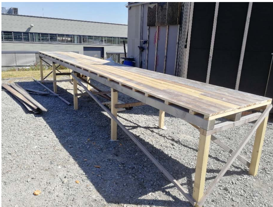
Obr. 13 – Opláštění konstrukce (zdroj: archiv autora)
