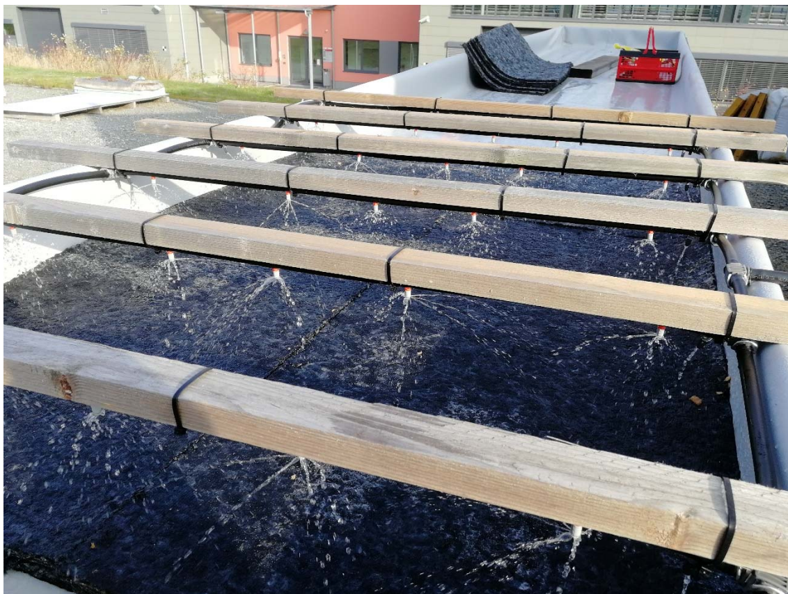
Obr. 21 – Rozprašovací trysky při průtoku vody závlahovým systémem (zdroj: archiv autora)
