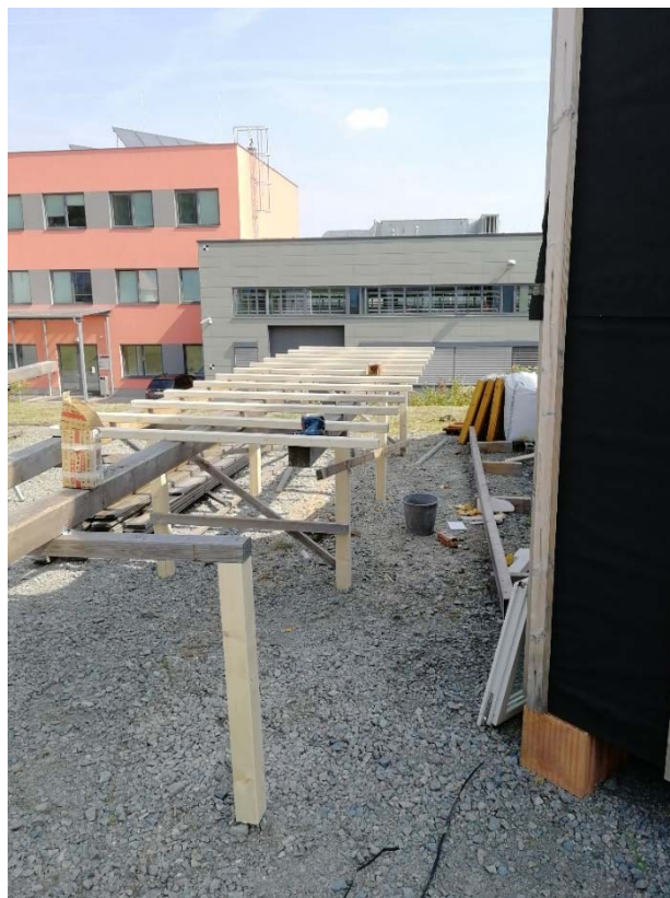
Obr. 11 – Výroba konstrukce (zdroj: archiv autora)
