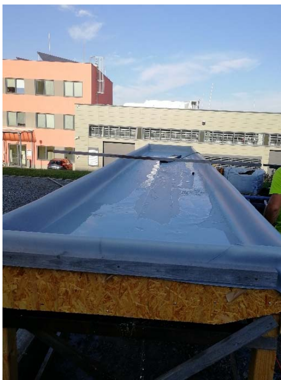
Obr. 14 – Finální konstrukce modelu (zdroj: archiv autora)
