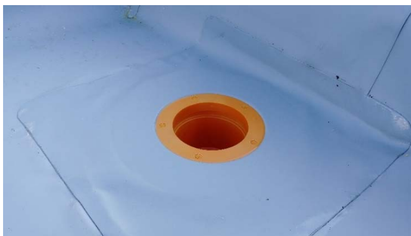
Obr. 16 – Osazení střešního vtoku (zdroj: autor)
