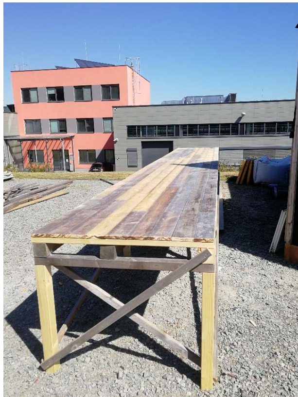
Obr. 12 – Opláštění konstrukce (zdroj: archiv autora)
