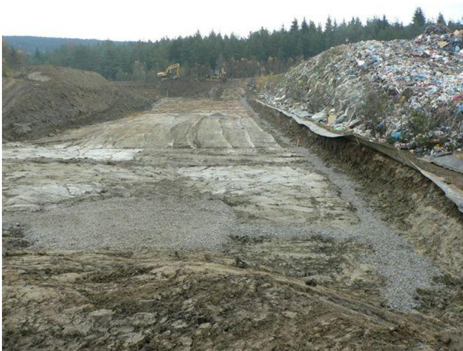
Foto č. 2 Úprava skládky Zdroj: vlastní
