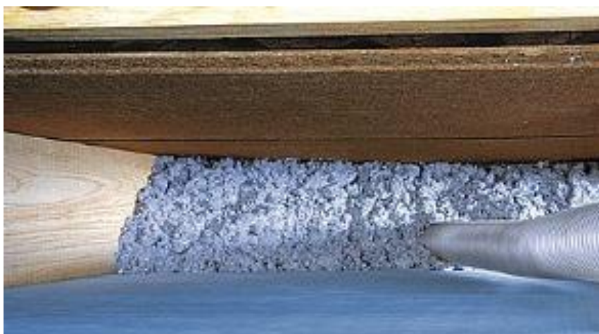
Obrázek 7: Izolace foukanou celulózou Zdroj: [ 24 http://www.stavebnictvi3000.cz ]
