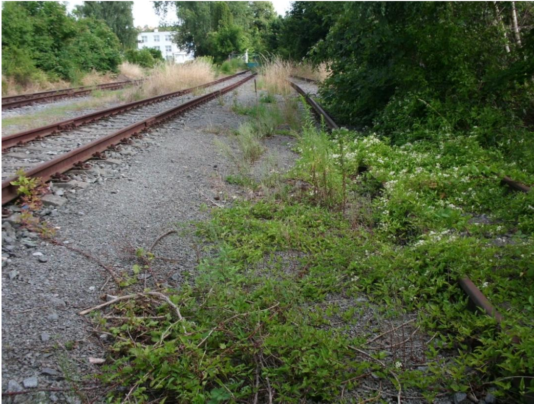
Obr. 12 Stanoviště nevyužívané železnice (rok 2015), Zdroj: vlastní fotodokumentace
