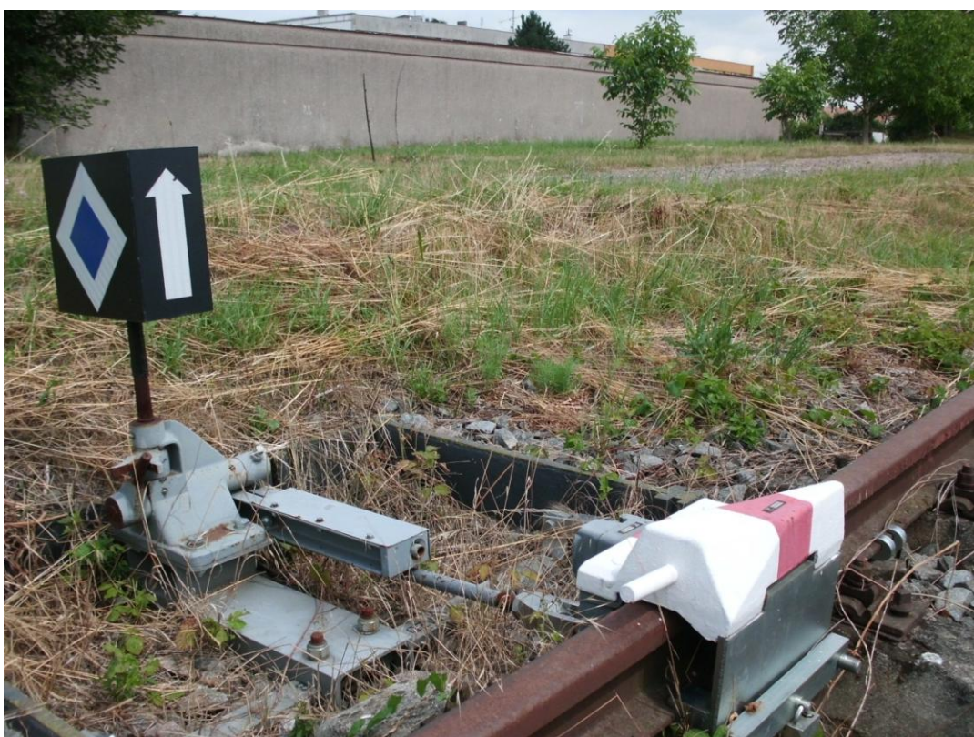
Obr. 15 Násep nevyužívané železnice, Zdroj: vlastní dokumentace
