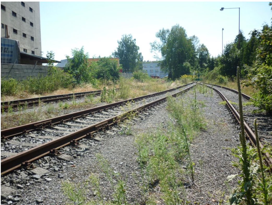
Obr. 13 Stanoviště nevyužívané železnice (rok 2013), Zdroj: vlastní fotodokumentace
