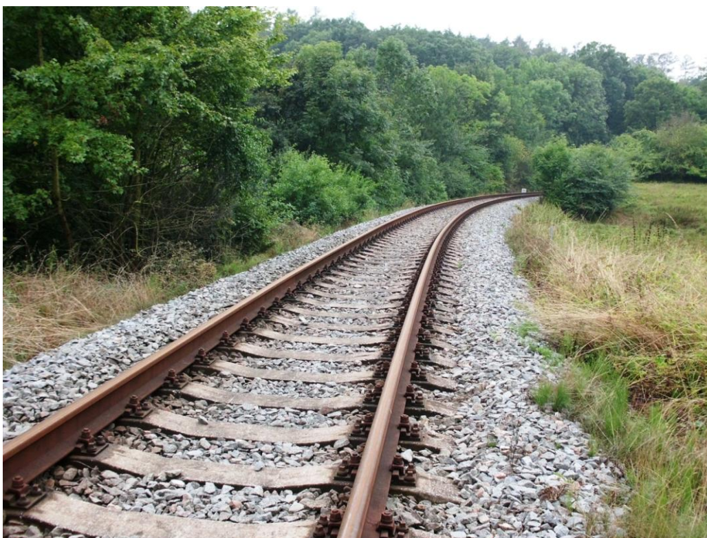
Obr. 11 Železniční trať vinoucí se přes přírodní rezervaci Habrov, Zdroj: vlastní fotodokumentace
