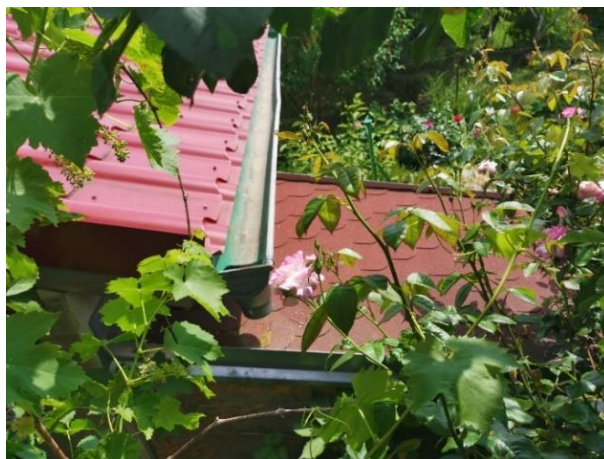
Obr. 4.95 - Plechová a živičná krytina na sousedních objektech (červená barva)
