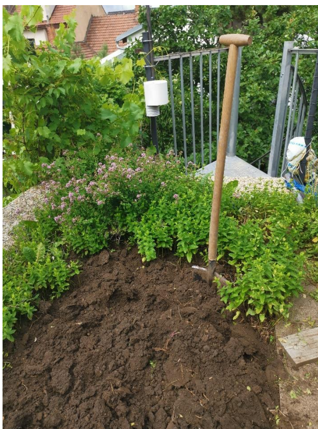
Obr. 3.2 – Intenzivní vegetační vrstva na objektu zahradního domku
