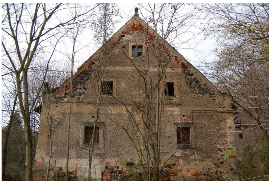
Obrázek 2: Budova pivovaru před rekonstrukcí
