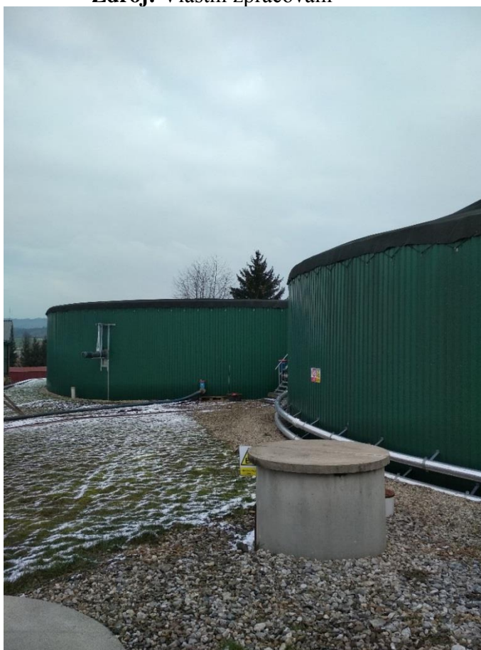
Fotografie č. 4 Fermentory na bioplynové stanici v Kunčíně I. Zdroj: Vlastní zpracování
