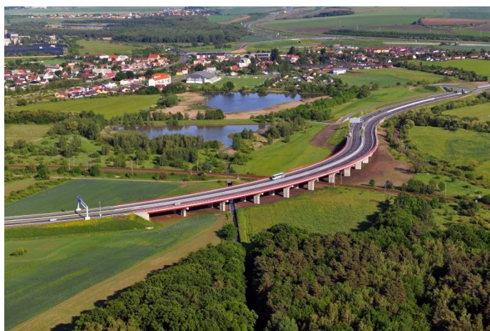
Obr. č. 6 Víceúčelový podchod pod komunikací D7
