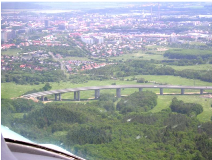
Obr. č. 23: Estakáda na silnici I/7
