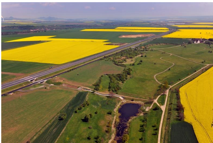
Obr. č. 15: Most na silnici D7 v km 2, 780
