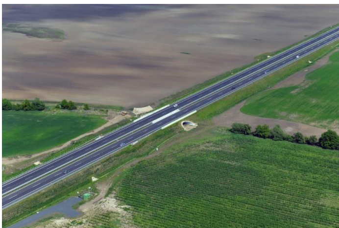
Obr. č. 18: Most na dálnici D7 pro biokoridor v km 7, 020
