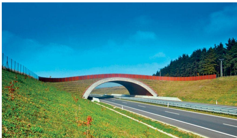
Obr. č. 7 Ekodukt D1 Mengusovce – Jánovce, III. Etapa, objekt C 231
