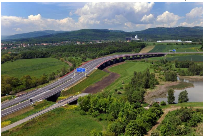
Obr. č. 21: Most na dálnici D7 nad vodotečí Lideňský přivaděč v km 14, 552 Most na dálnici D7 nad tratí ČD v km 14, 707 – 15, 062
