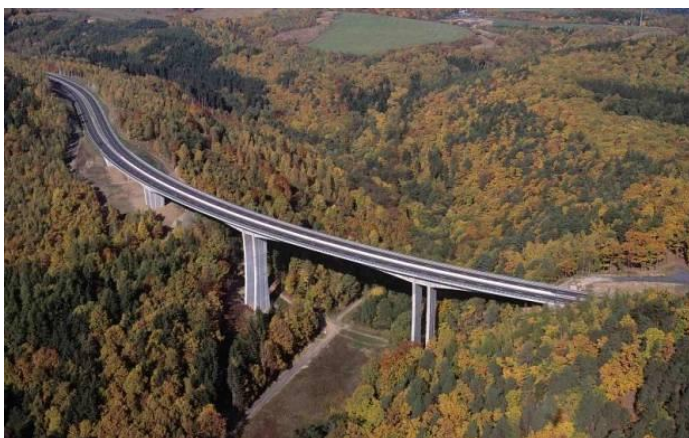
Obr. č. 24: Most na silnici I/7 přes údolí Hačky
