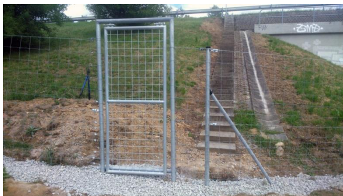
Obr. č. 42: Nový způsob uchycení branky ze shora použitý na D1
