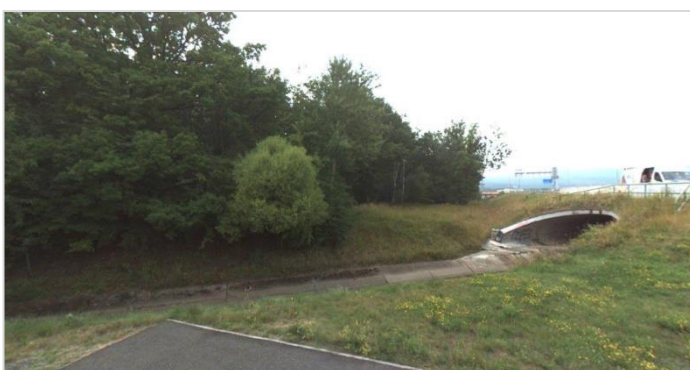
Obr. č. 22: Most na silnici I/7 přes podkrušnohorský přivaděč
