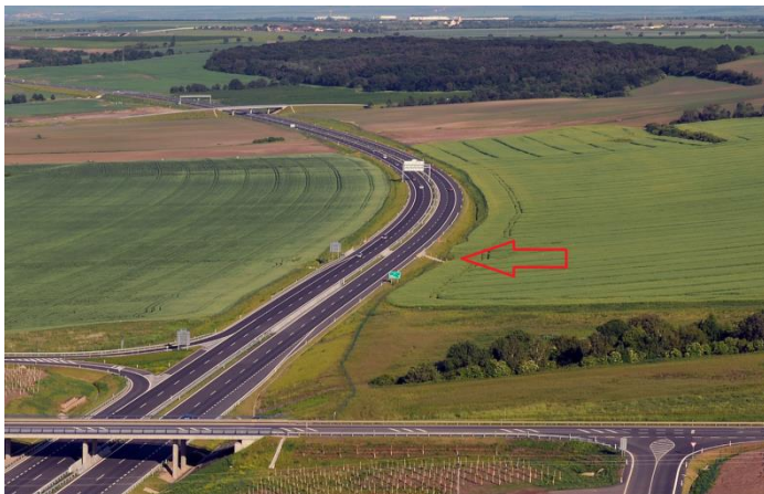
Obr. č. 19: Most na dálnici D7 pro biokoridor v km 8, 640
