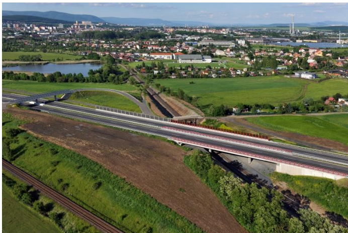
Obr. č. 20: Most na dálnici D7 nad tratí v km 14, 081
