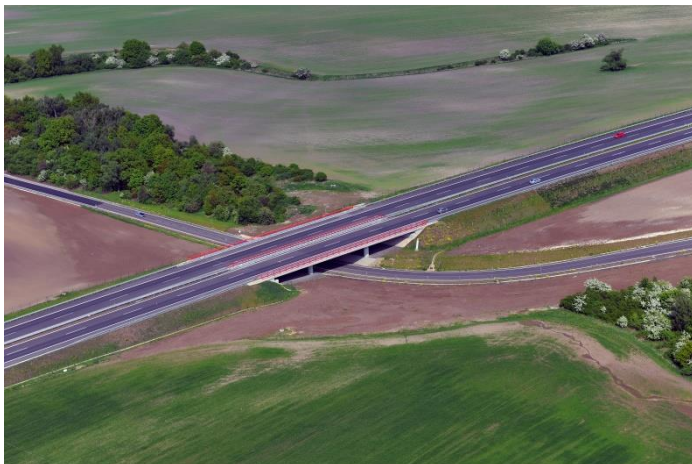
Obr. č. 17: Most na dálnici D7 v km 6, 280
