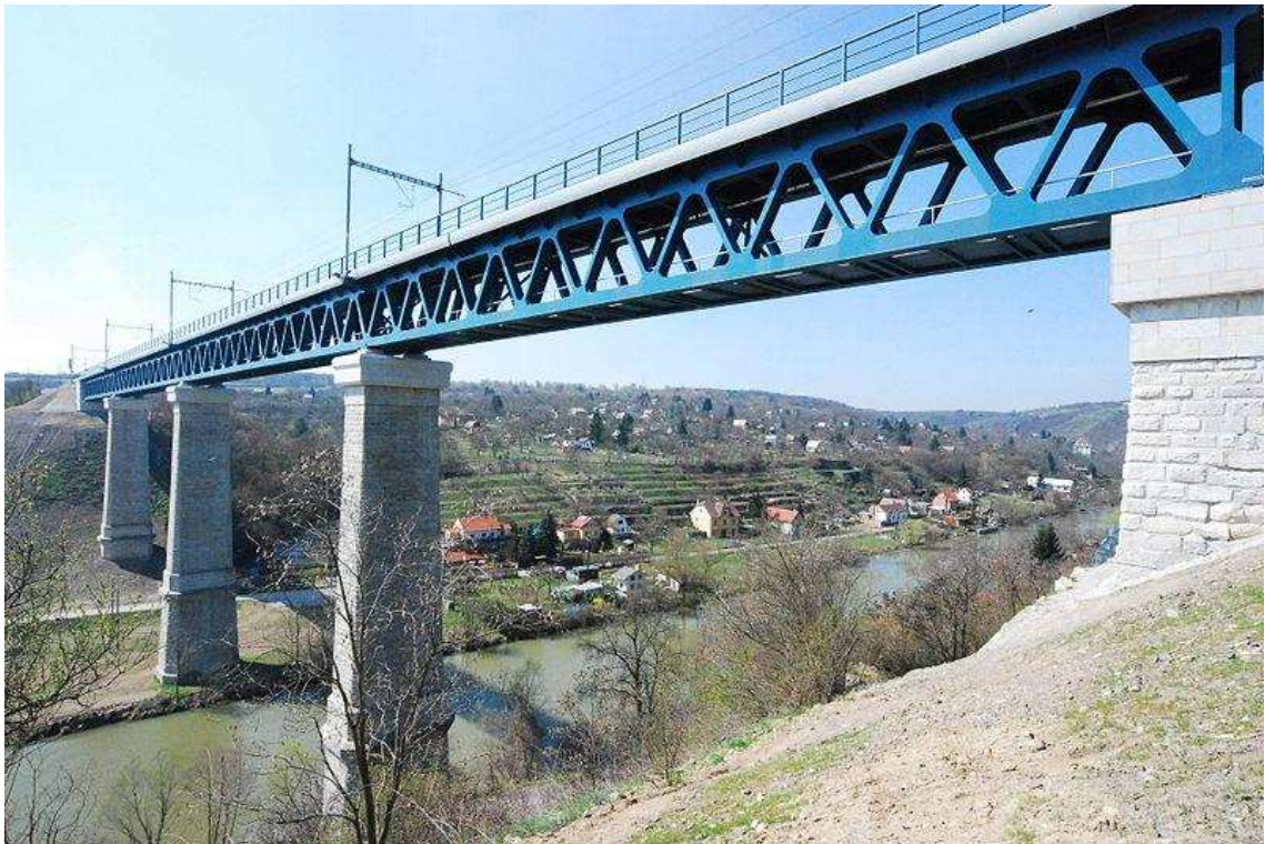
Obr. 2 Zrekonstruovaný znojemský viadukt
