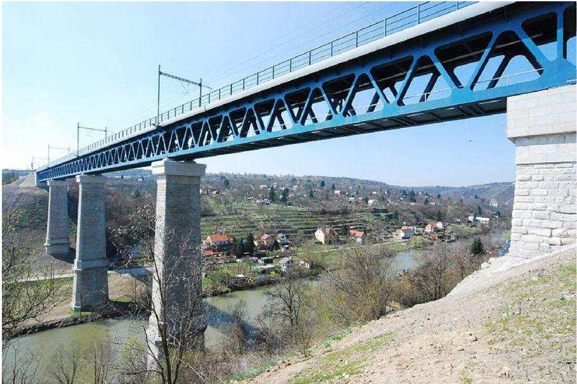
Obr. 2 Zrekonstruovaný znojemský viadukt
