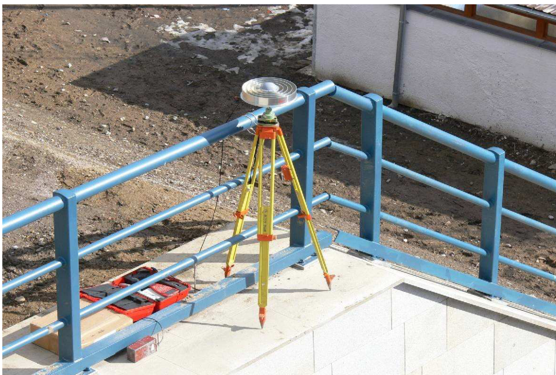
Obr. 5 Referenční stanice GNSS na bodě TARS
