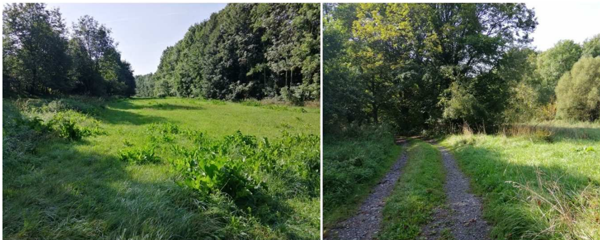
Obr. 4.1 Parcela pro vybudování ČOV a stávající příjezdová cesta [16]
