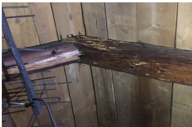
Obrázek 39: Poškození východní krokve požerky tesařika
