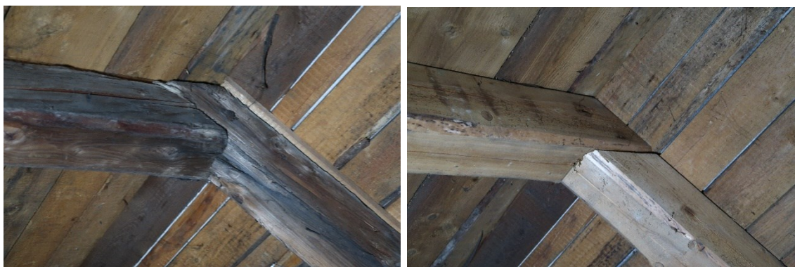
Obrázek 31: Původní krokve spojené na čep a rozpor
