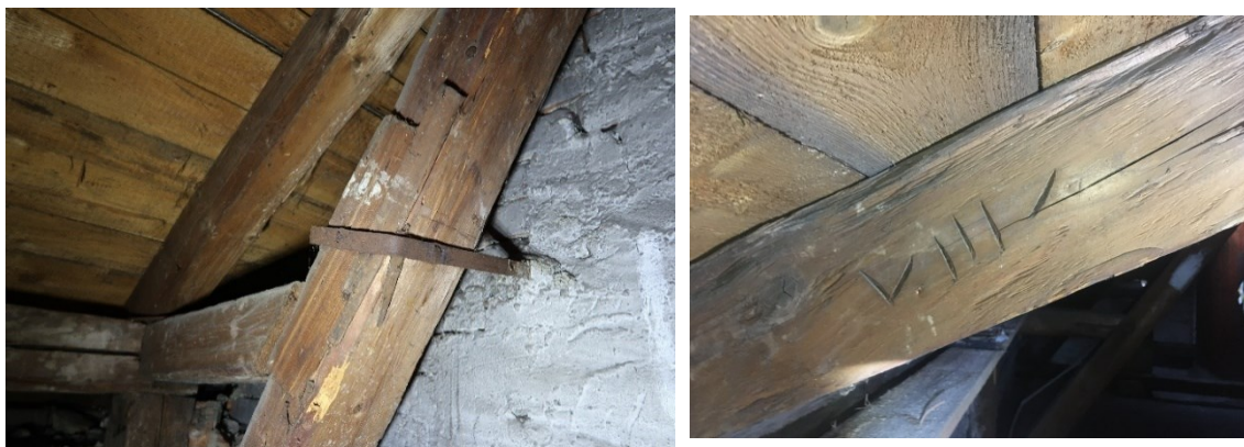
Obrázek 29: Kotvení konstrukce pomocí ocelové skoby do zdiva
