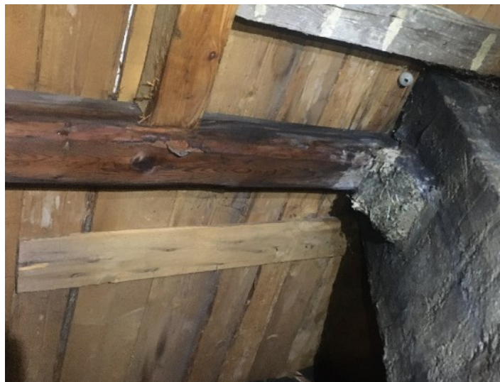
Obrázek 40: Západní část vazby procházející komínem
