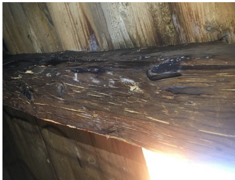
Obrázek 37: Západní část vazby; mycelium trámovky na krokvi
