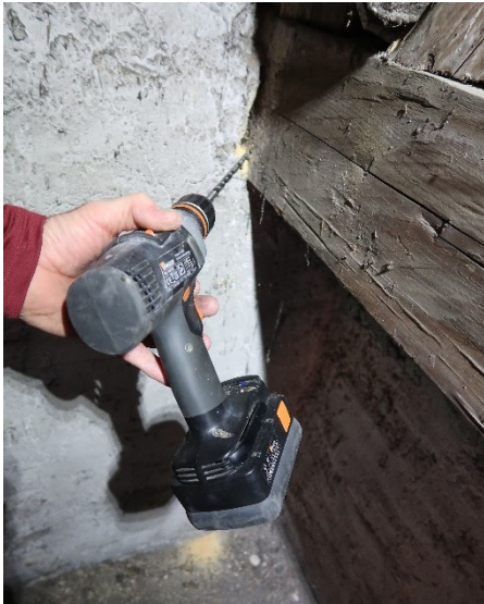
Obrázek 23: Příprava vrtu pro umístění kamery endoskopu
