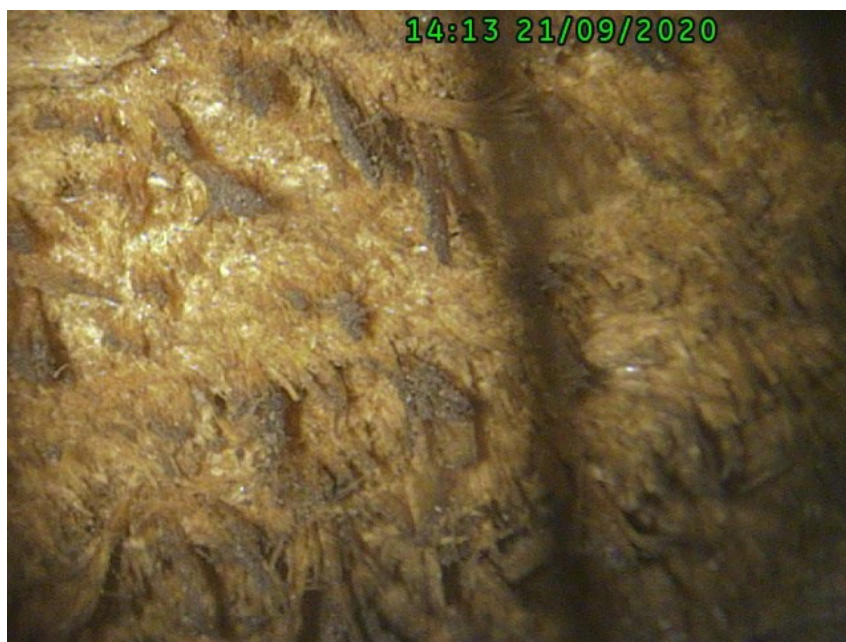
Obrázek 49: Snímek pořízený endoskopem – čelo, vazný trám, vazba č.16
