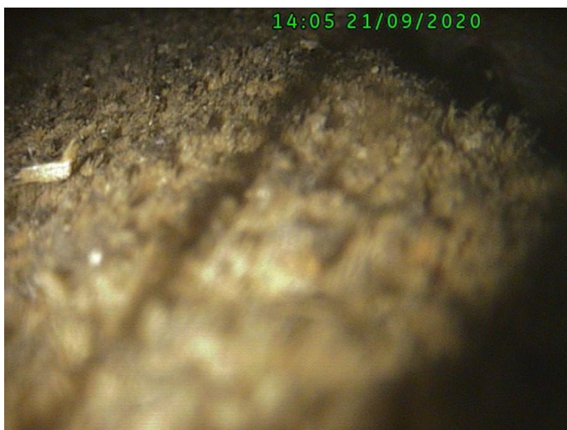
Obrázek 47: Snímek pořízený endoskopem – čelo, vazný trám, vazba č.13
