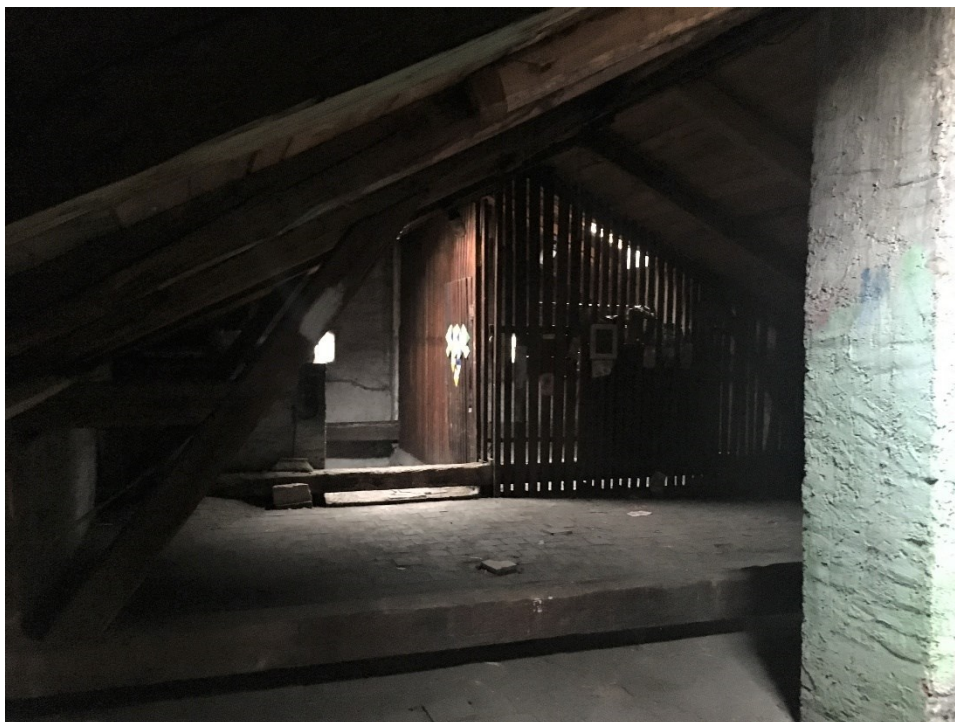
Obrázek 27: Pohled na severní stranu konstrukce
