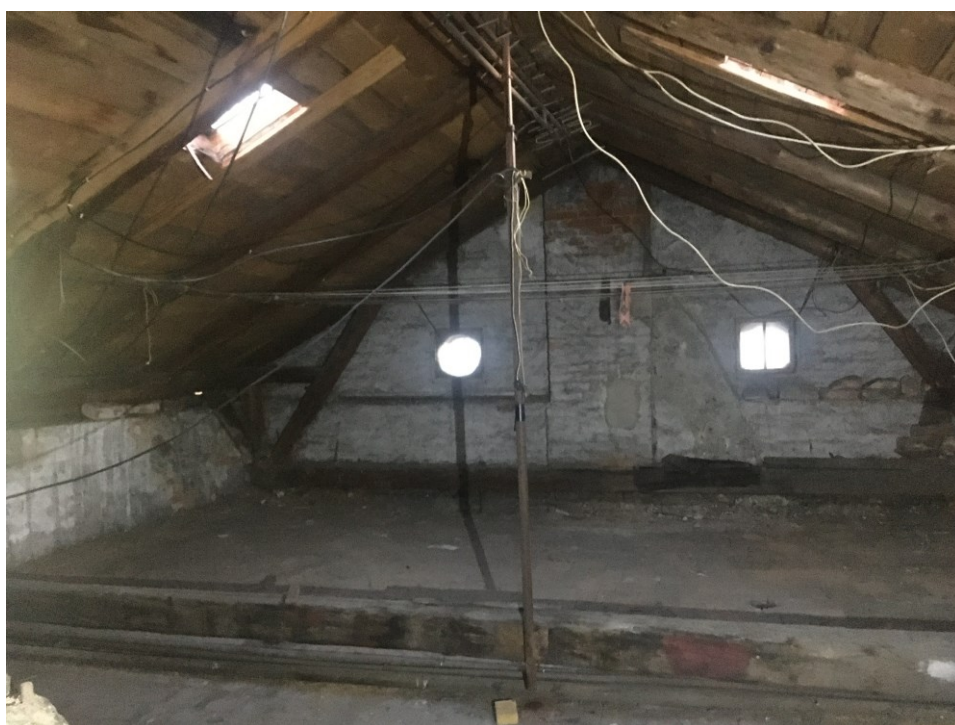
Obrázek 28: Pohled na jižní stranu konstrukce
