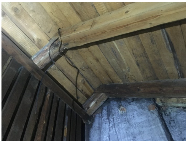
Obrázek 43: Vyměněný prvek krokve ve vazbě
