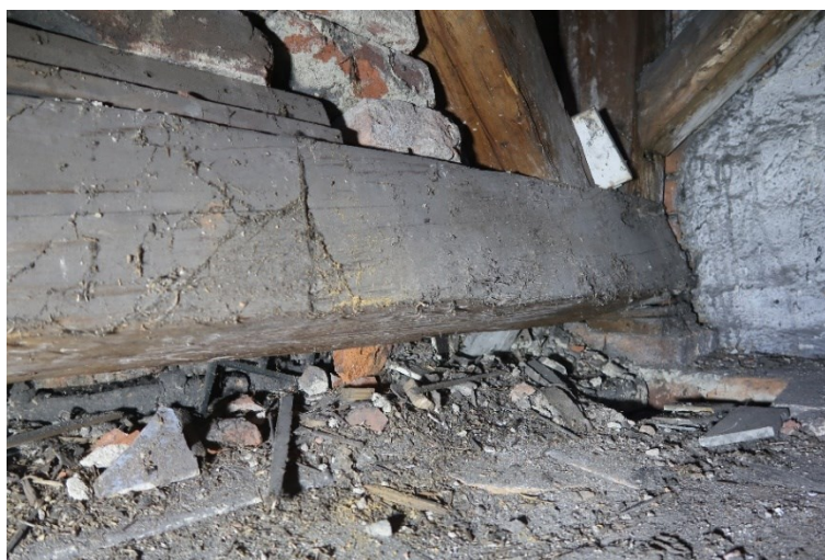
Obrázek 55: Západní část vazby; podložení točivého vazného trámu
