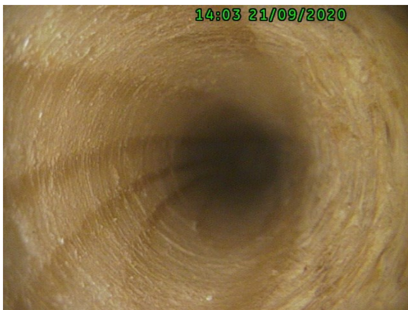
Obrázek 46: Snímek pořízený endoskopem – vazný trám, vazba č.13
