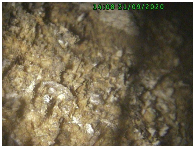
Obrázek 45: Snímek pořízený endoskopem – čelo, vazný trám, vazba č.10
