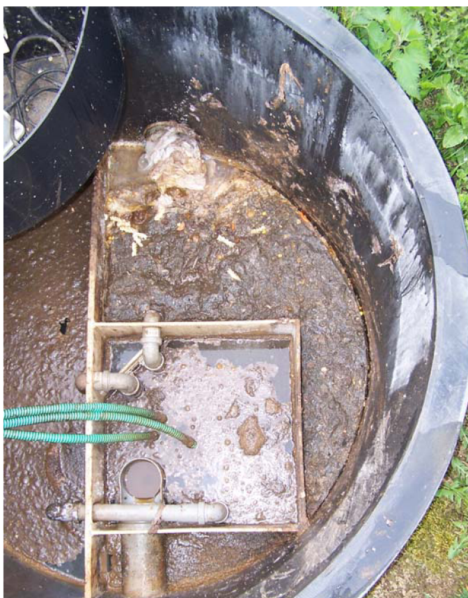
Obr. 3.3 Zanedbávaná DČOV [zdroj Sakáčová dne 16. 4. 2016]
