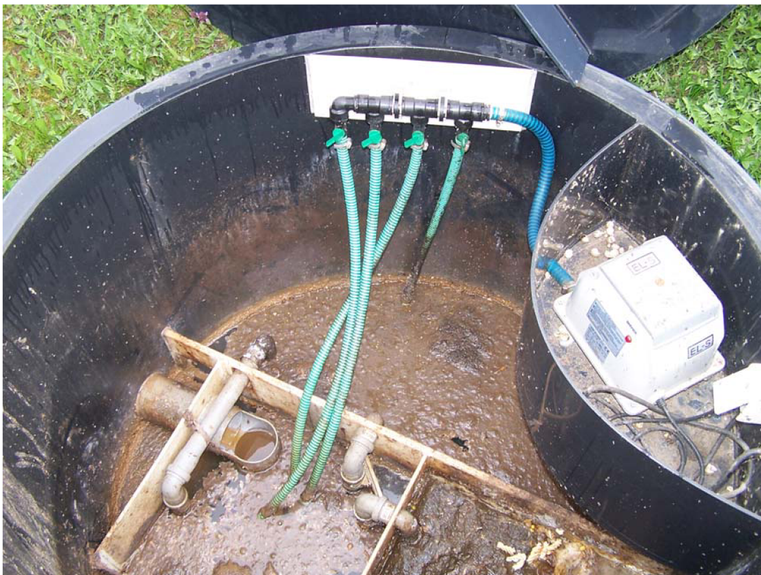
Obr. 3.3 Zanedbávaná DČOV [zdroj Sakáčová dne 16. 4. 2016]
