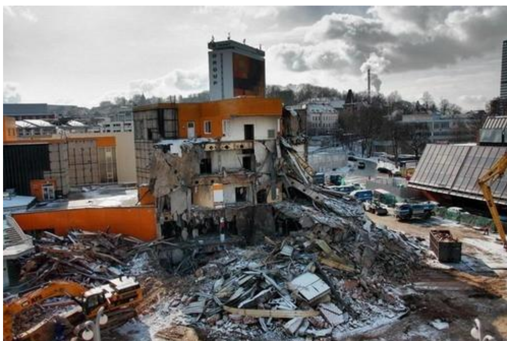
Obrázek 55: Demolice obchodního domu Tesco, pohled z Jánské ulice
