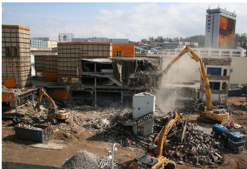
Obrázek 57: Těžká technika demolující obchodní dům
