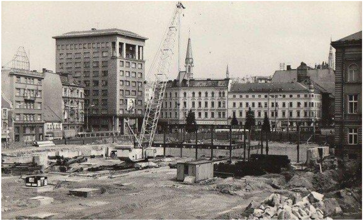
Obrázek 32: Budování základů OD Ještěd
