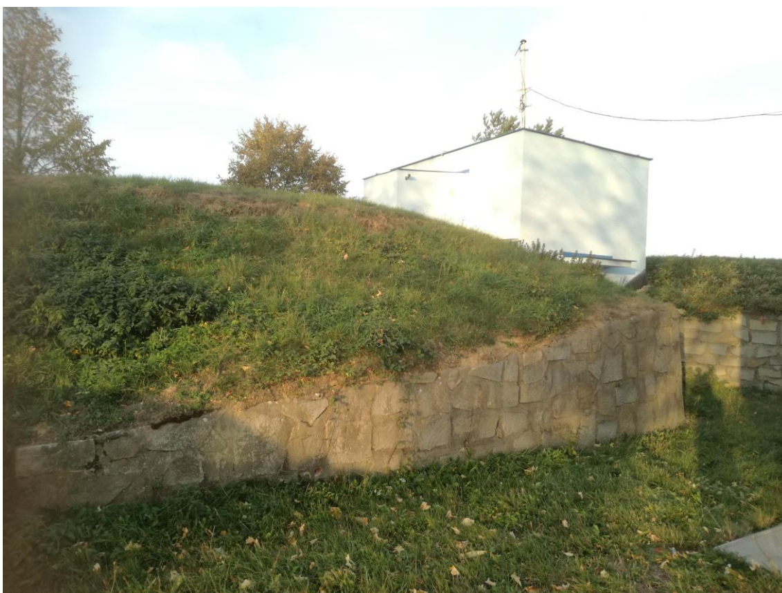
Obr. 4.4 Vodojem Velký Beranov nový
