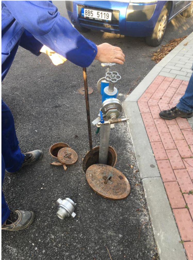
Obr. 4.6 Proplach hydrantu a následné osazení tlakového čidla SEBA
