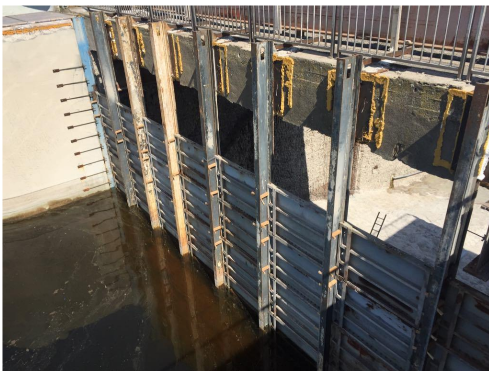
Obrázek 42: Rekonstrukce krajního pole bezpečnostního přelivu (autor Jan Gráf)
