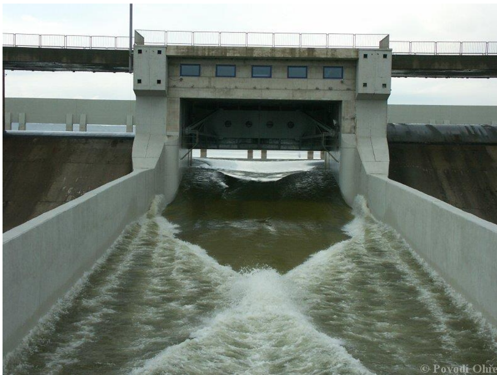
Obrázek 35: Rekonstruované střední pole bezpečnostního přelivu (POH, ©2019)
