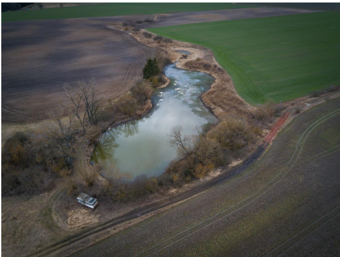
Foto č. 9 - Bezejmenná nádrž ; zdroj: vlastní
