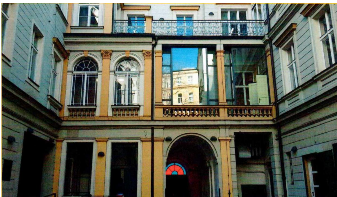
Obr. 12 Fotografie posuzované stavby
