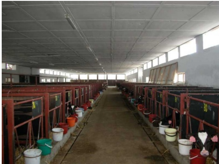
Obr. 5: PIB 2 (zrekonstruovaný zateplený teletník)
