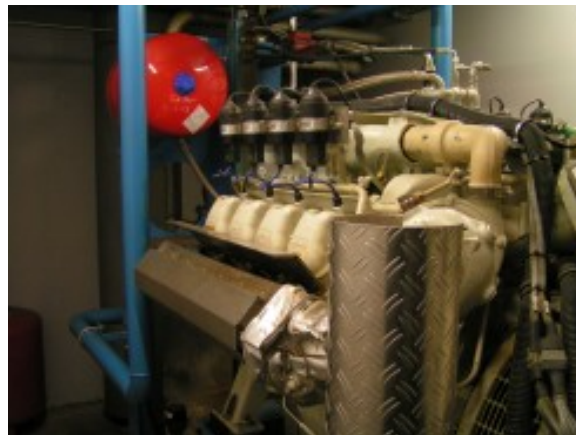
Obr. 8 – Pohled na motor poháněný bioplynem ve strojovně
