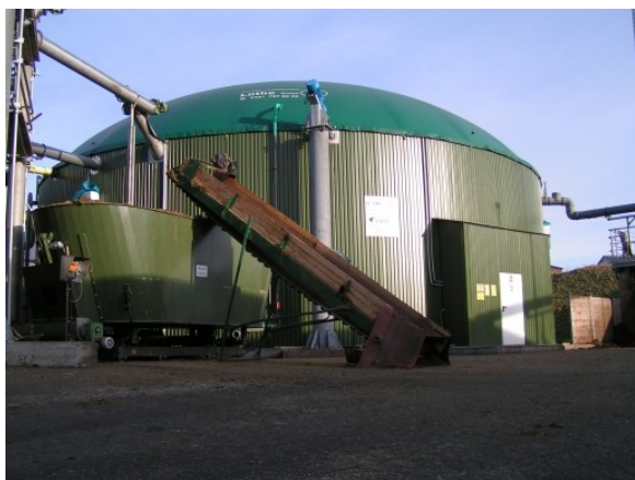
Obr. 1 - Pohled na bioplynovou stanici OD Soběšice
