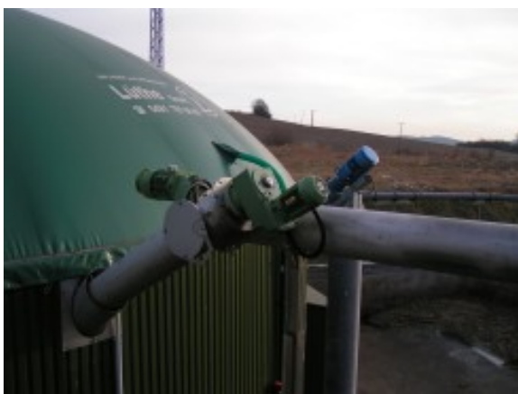
Obr. 4 - Substrát při výstupu z reaktoru
